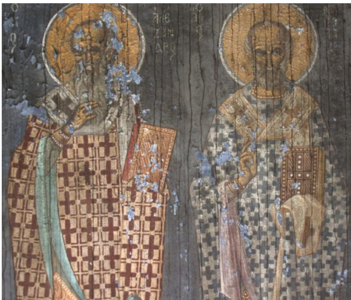
Βλάβες στον τοιχογραφικό διάκοσμο του Ι.Ν. Αναστάσεως
