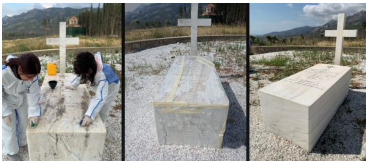
Εργασίες απομάκρυνσης βιολογικών επικαθίσεων στα ταφικά μνημεία
