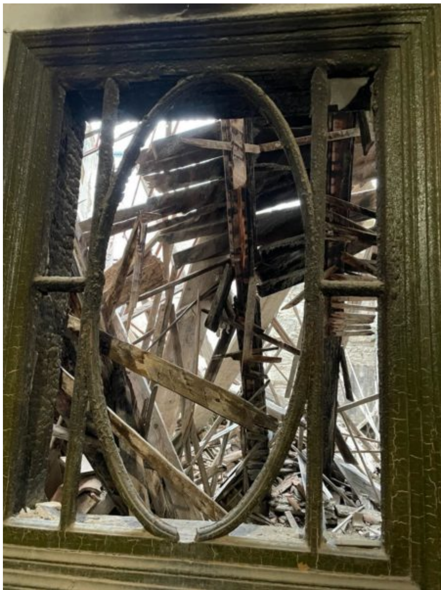
Το προς αποκατάσταση κτίριο του Ελληνικού Ωδείου Αθηνών (Μέγαρο Prokesch von Osten)
