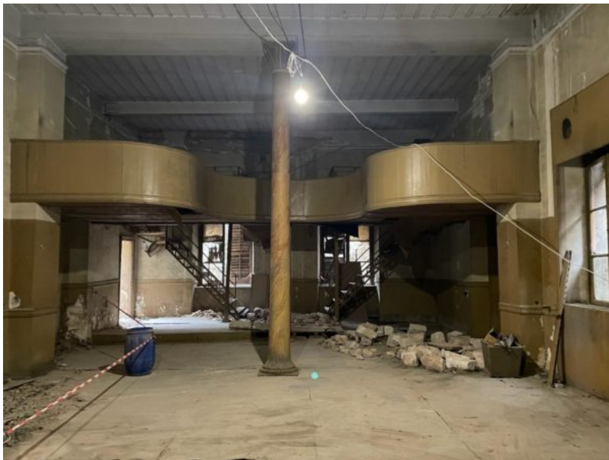
Το προς αποκατάσταση κτίριο του Ελληνικού Ωδείου Αθηνών (Μέγαρο Prokesch von Osten)
