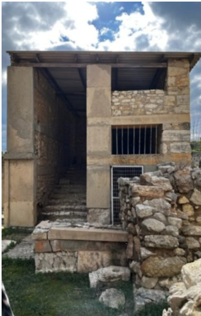
Άποψη του «Κλιμακοστασίου», Βόρεια Όψη
