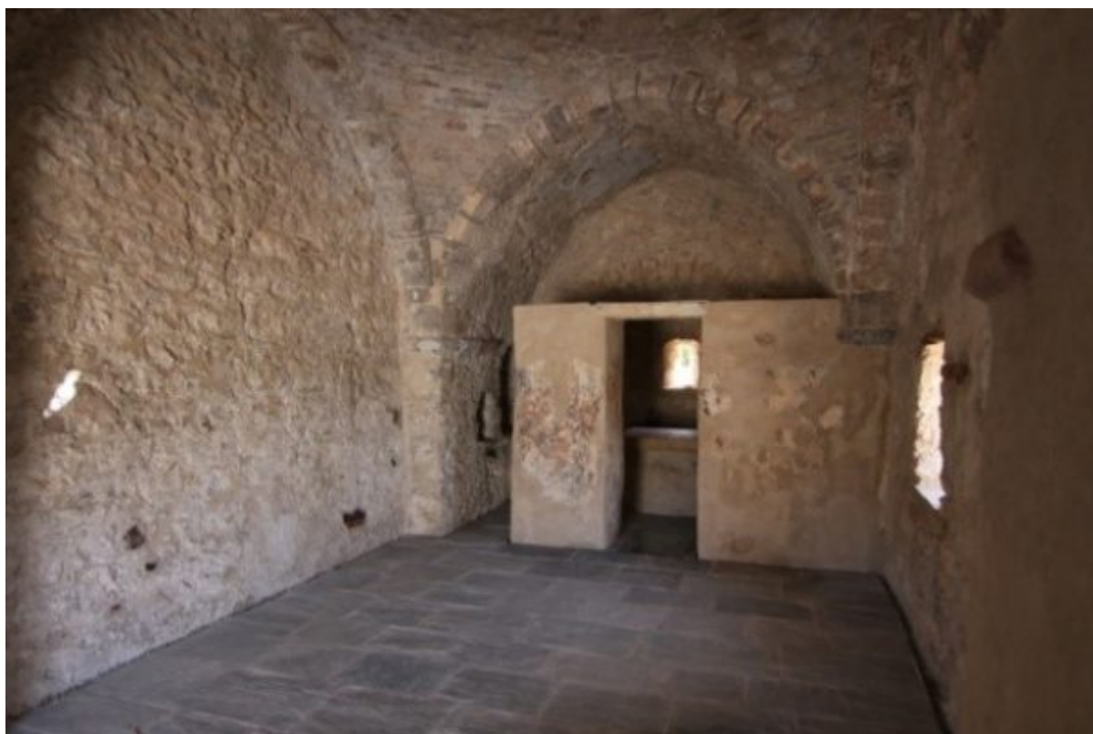
Μετά τις εργασίες αποκατάστασης
