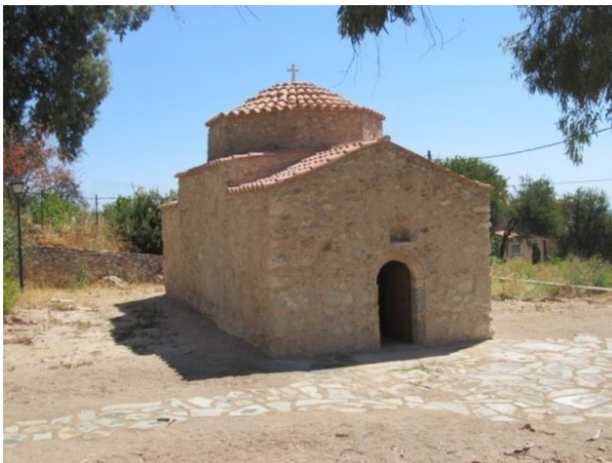
Μετά τις εργασίες αποκατάστασης
