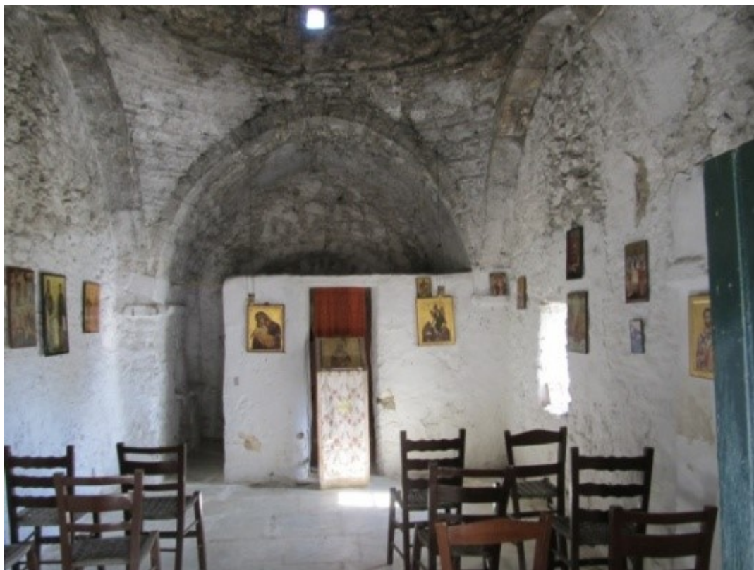
Πριν τις εργασίες αποκατάστασης
