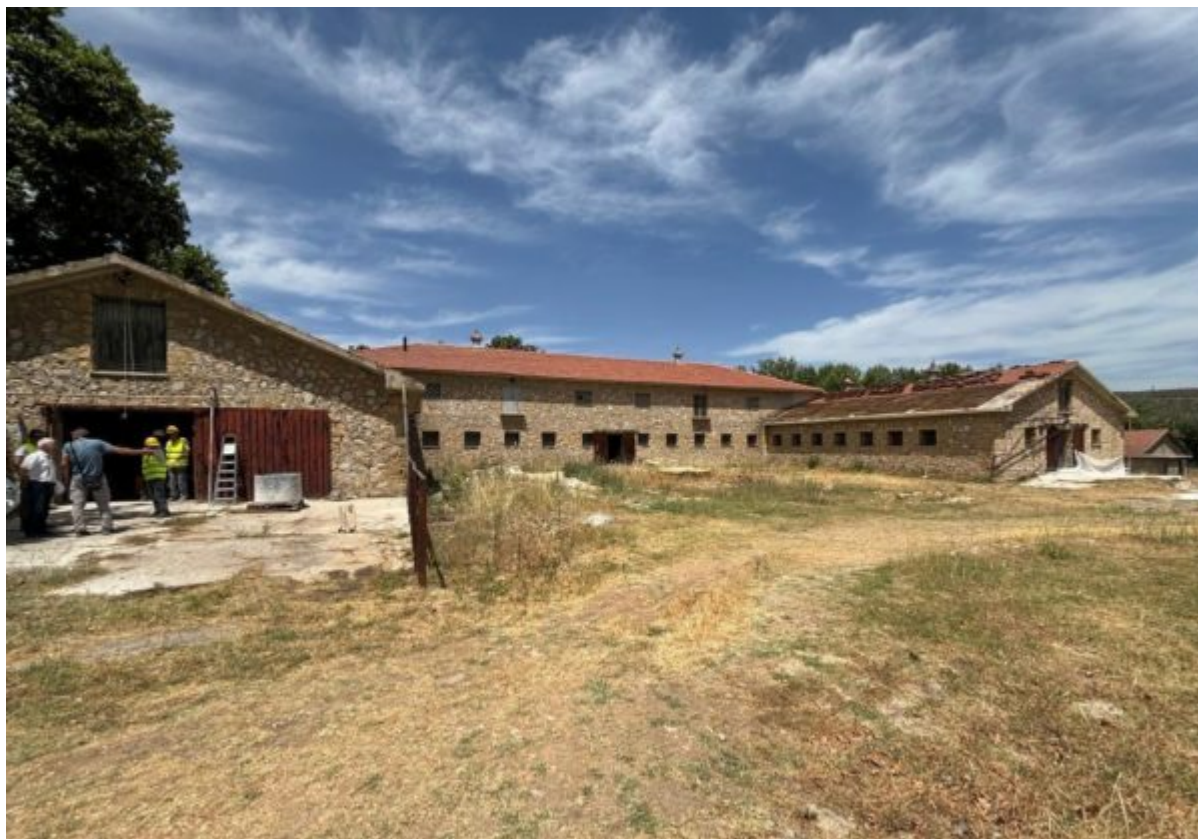
Άποψη από το κτηριακό συγκρότημα του νέου Βουστασίου
