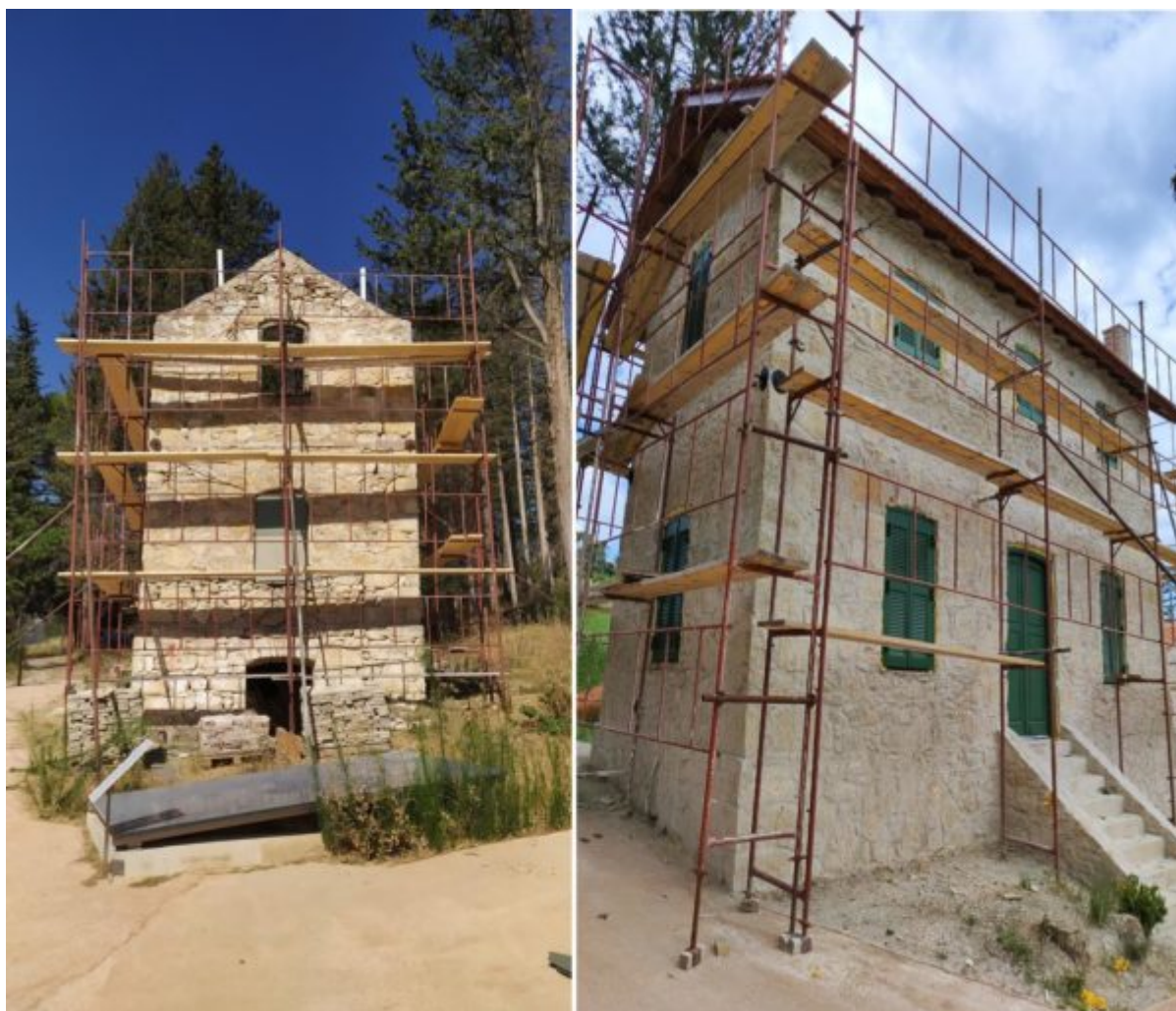
Οικία Αρχικηπουρού πριν και μετά τις εργασίες αποκατάστασης
