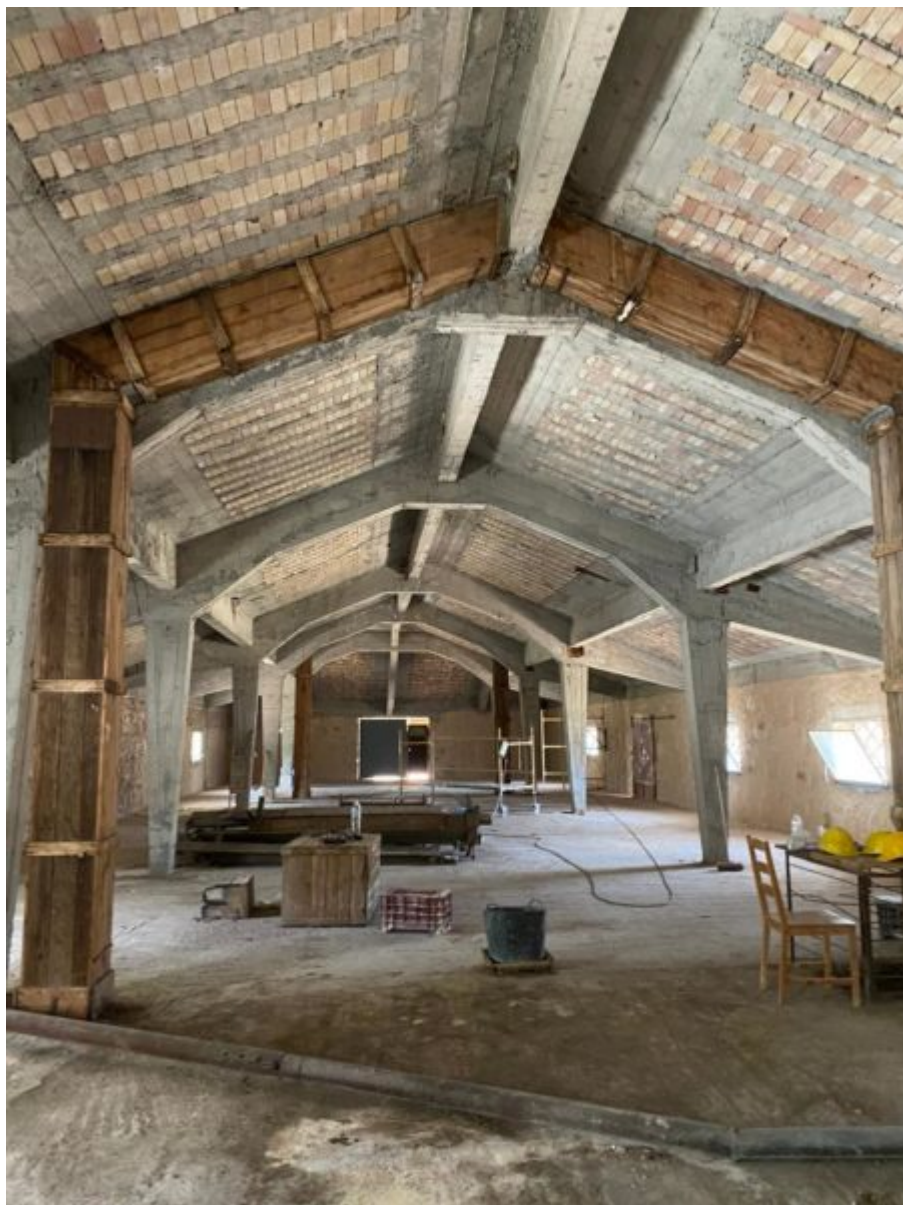
Άποψη από το εσωτερικό του νέου Βουστασίου β' όροφος
