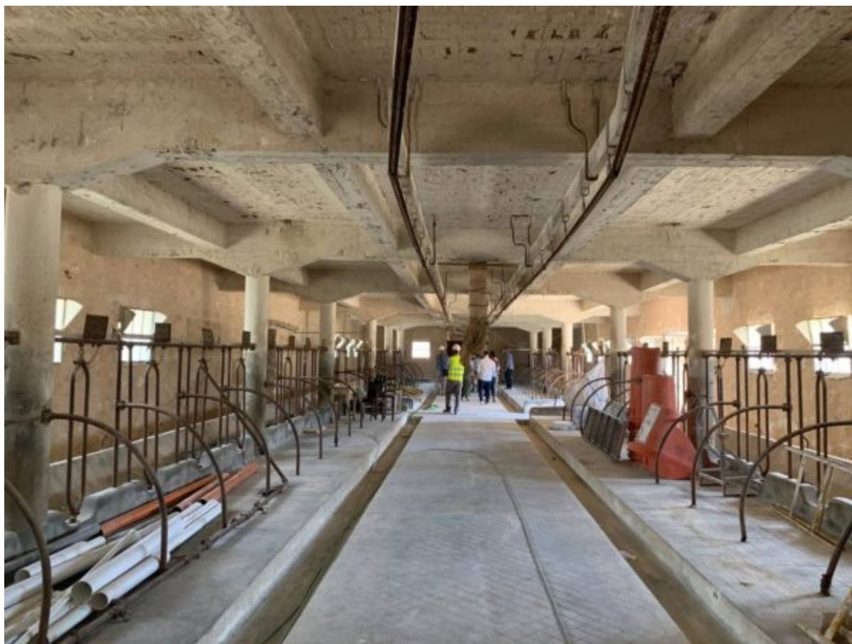
Εργασίες αποκατάστασης του νέου Βουστασίου
