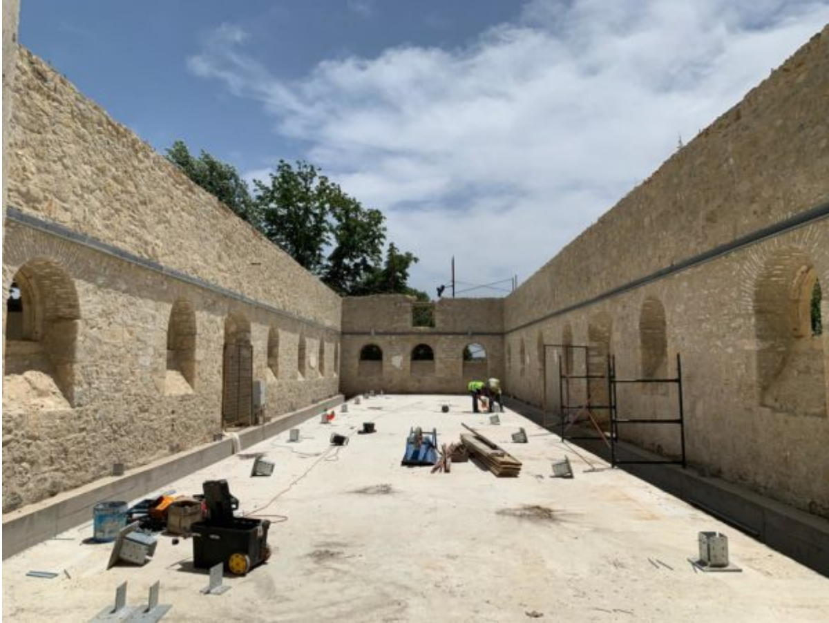
Εργασίες σε εξέλιξη στο παλαιό Βουστάσιο
