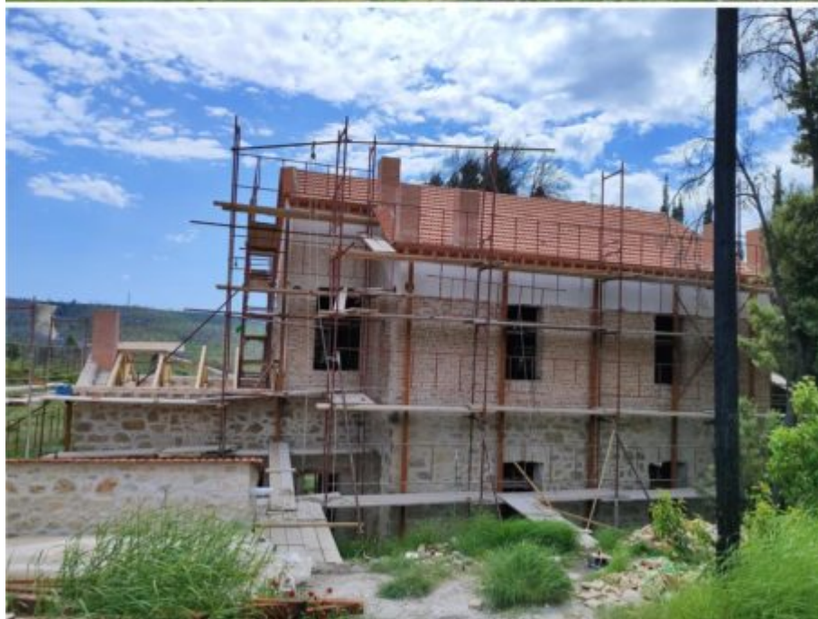
Οικία Στουρμ. Πριν και μετά την αποκατάσταση
