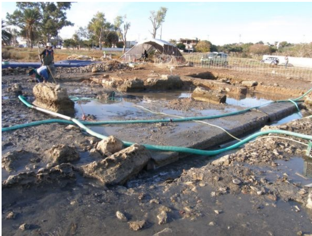
Εικ. 4. Σαλαμίσ, Αμπελάκι. Αποψη τμήματος του χώρου της 'αμφίβιας' ανασκαφής του 2023, με τον στιβαρό ανατολικό (πίσω) τοίχο του μεγάλου κτηρίου, μπροστά (από τα νοτιοανατολικά)
