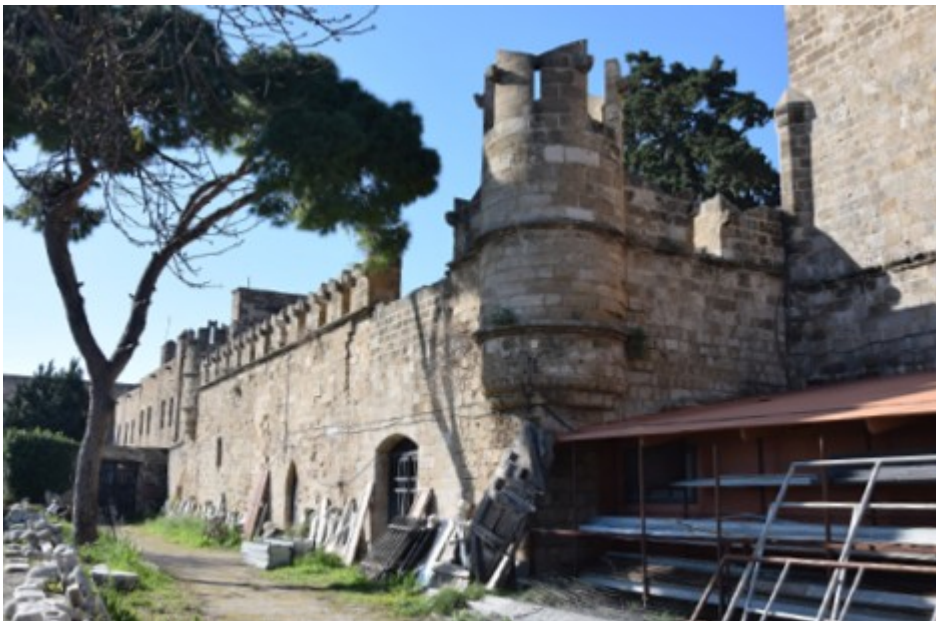
Το νότιο κτήριο του Νομισματοκοπείου (βορειοανατολική όψη)
