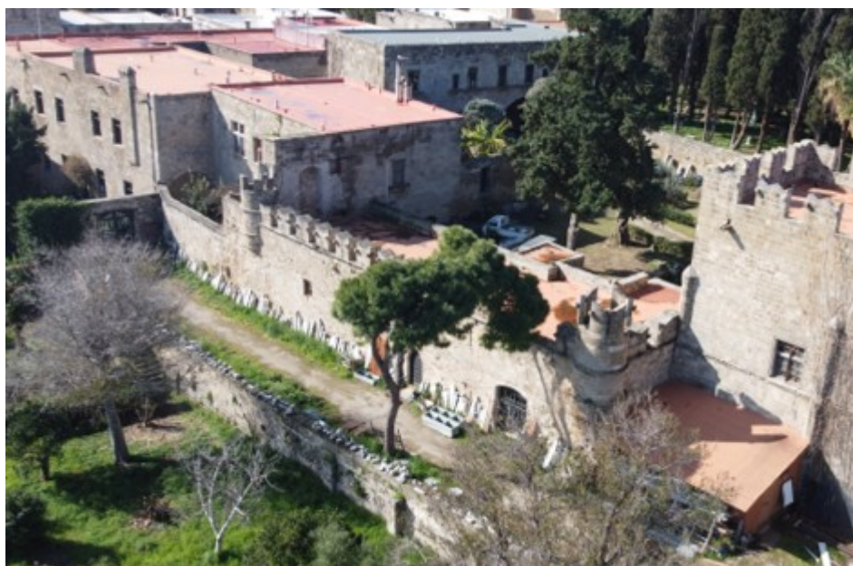
Γενική άποψη του νοτίου κτηρίου (το οποίο στεγάζει το σιδηρουργείο και μικρή αίθουσα ξυλουργείου) από τα βορειοανατολικά
