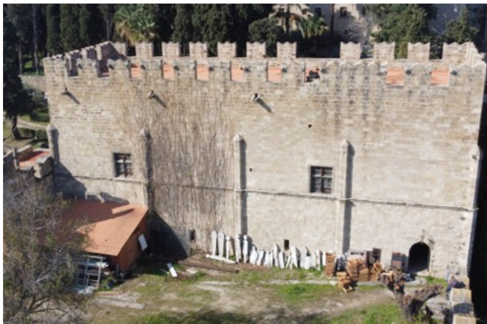
Το βόρειο κτήριο του Νομισματοκοπείου (ανατολική όψη)
