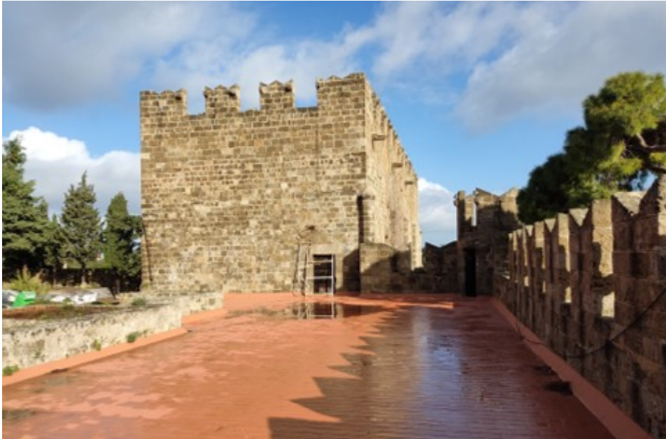
Άποψη του νότιου τοίχου του βόρειου κτηρίου του Νομισματοκοπείου
