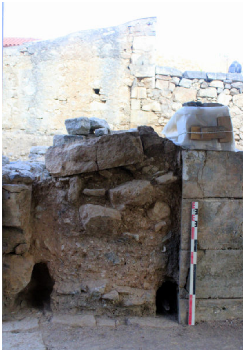
Θύρα εισόδου του δυτικού τοίχου μετά το πέρας των εργασιών
