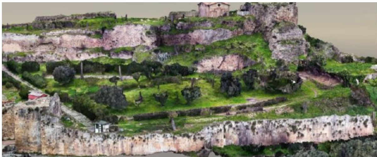
Άποψη του Β τμήματος. Υφιστάμενη κατάσταση
