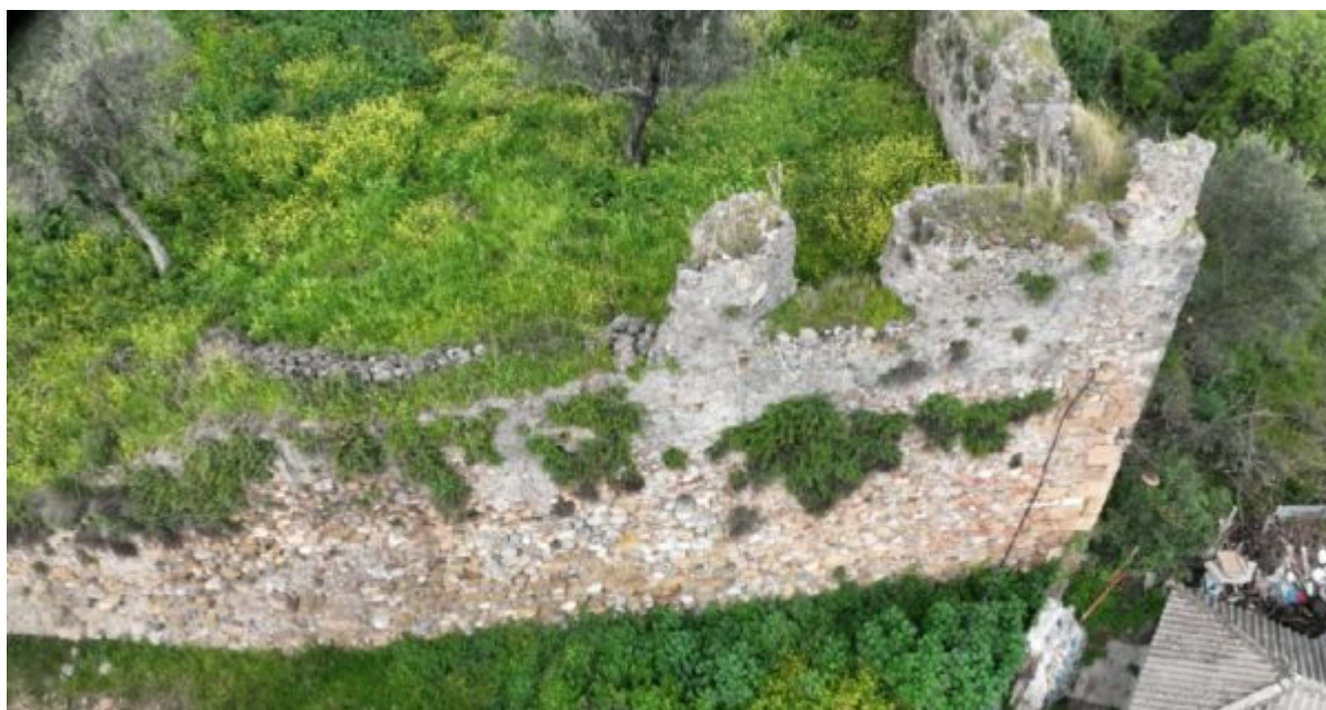
Άποψη του Γ τμήματος. Υφιστάμενη κατάσταση
