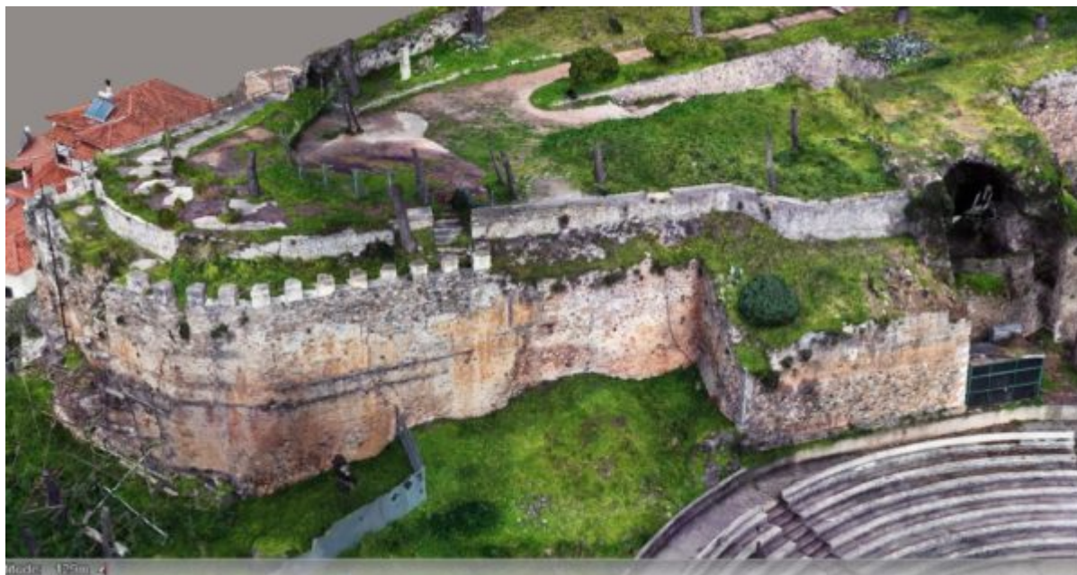
Άποψη του Ε τμήματος. Υφιστάμενη κατάσταση
