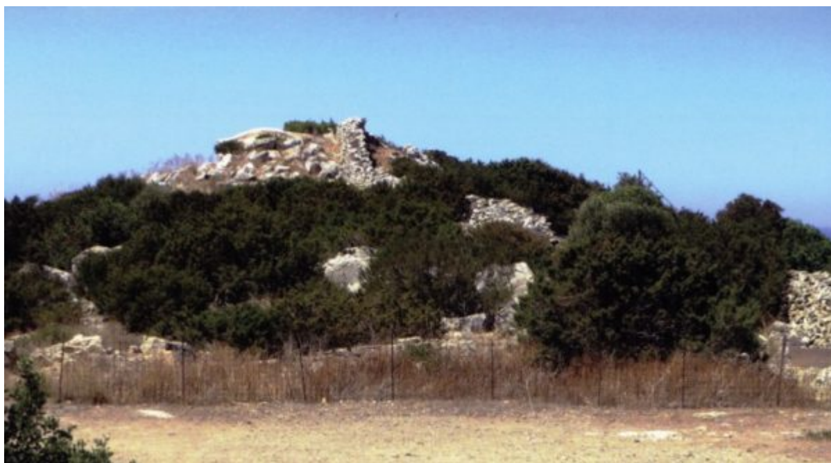
Άποψη του αρχαιολογικού χώρου με την πρόχειρη περίφραξη. Υφιστάμενη κατάσταση τείχους
