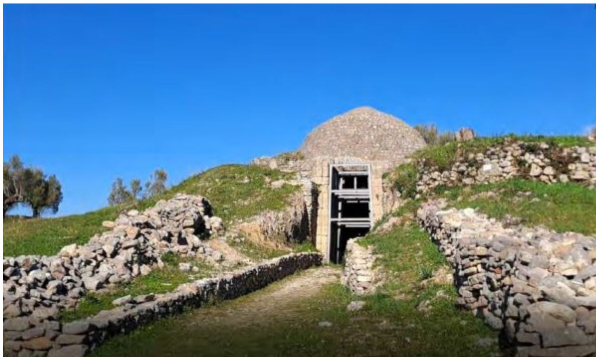
Η σημερινή κατάσταση της εισόδου και του δρόμου του θολωτού τάφου
