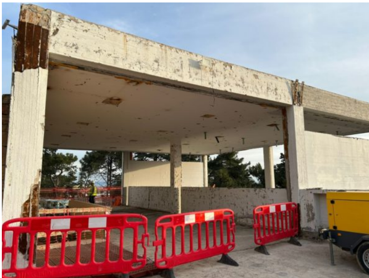
Στο εργοτάξιο του Αρχαιολογικού Μουσείου Χίου εξελίσσονται με ταχείς ρυθμούς οι εργασίες για τον εκσυγχρονισμό και την επέκταση του κτηρίου
