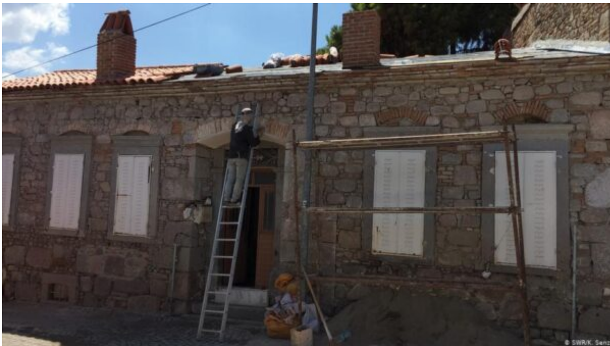
Έργα αποκατάστασης της στέγης σε κτήρια του 19ου αιώνα
