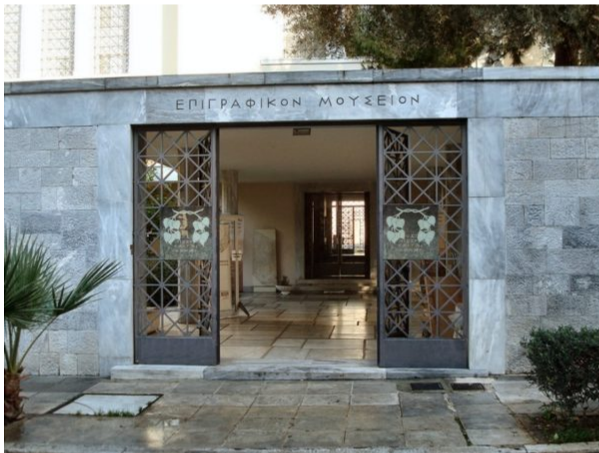
Άποψη της εισόδου του Επιγραφικού Μουσείου. Υφιστάμενη κατάσταση
