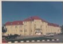
TRIM - BOMBA - CERNICU gandria
