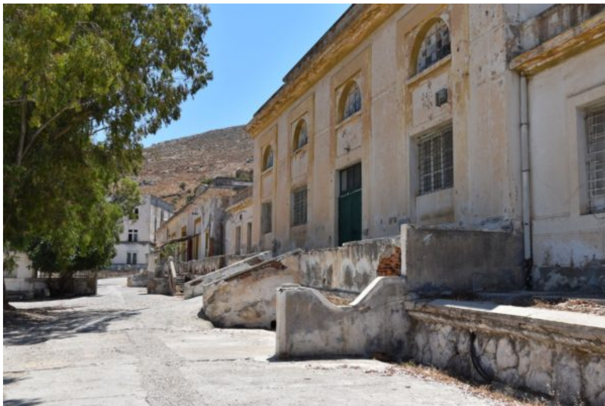
Άποψη των κτηρίων στην αεροναυτική βάση στα Λέπιδα
