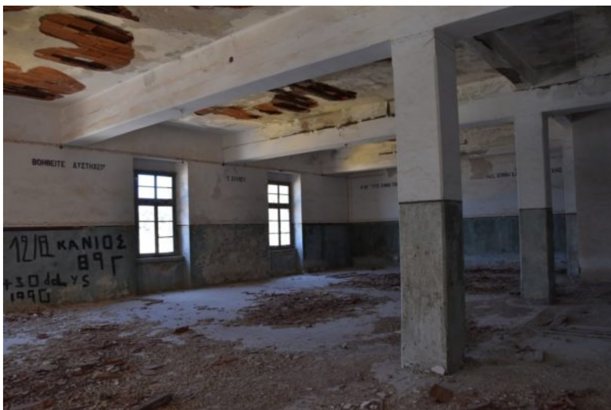
Άποψη του εσωτερικού των κτηρίων των πρώην Βασιλικών Σχολών
