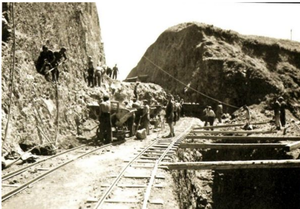
Εργασίες για την τομή υπό την επίβλεψη Γερμανού επόπτη
