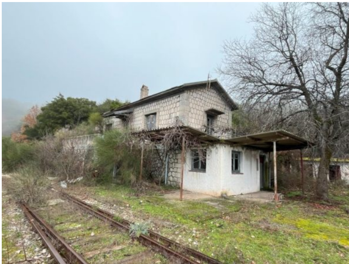
Το βοηθητικό πέτρινο κτήριο. Υφιστάμενη κατάσταση
