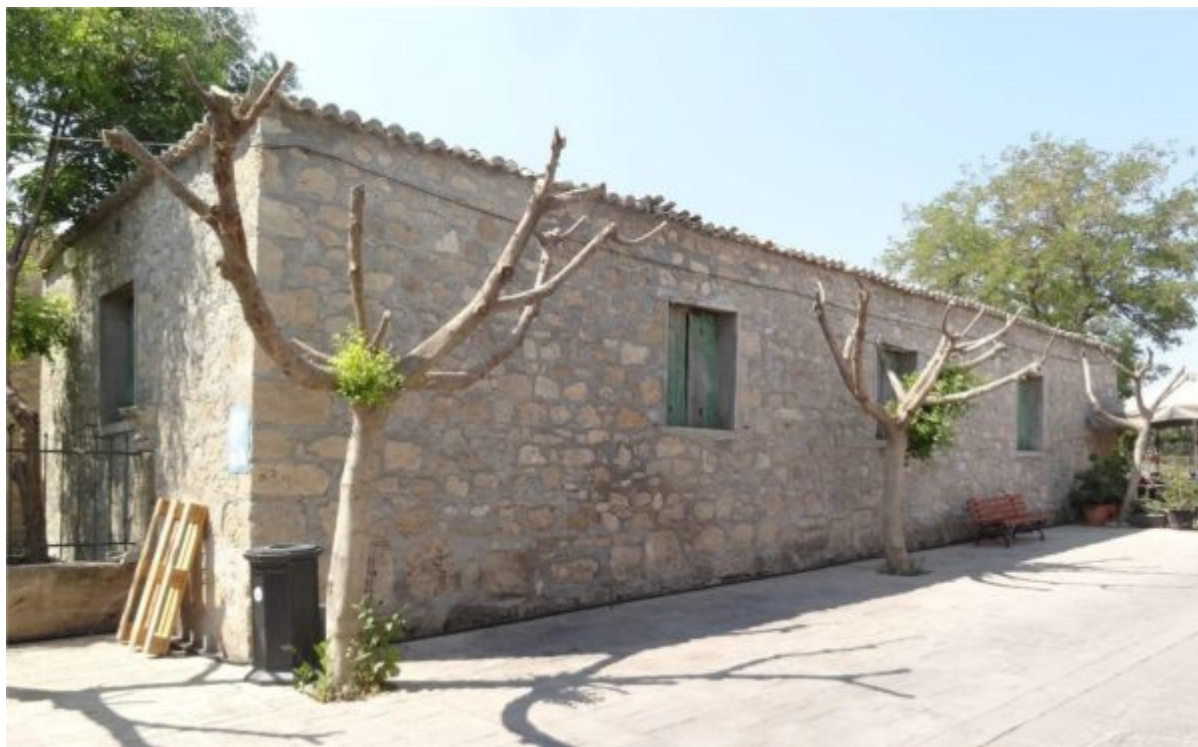
Το κτήριο που θα στεγάσει το πωλητήριο του ΟΔΑΠ. Όψη προς τον πεζόδρομο
