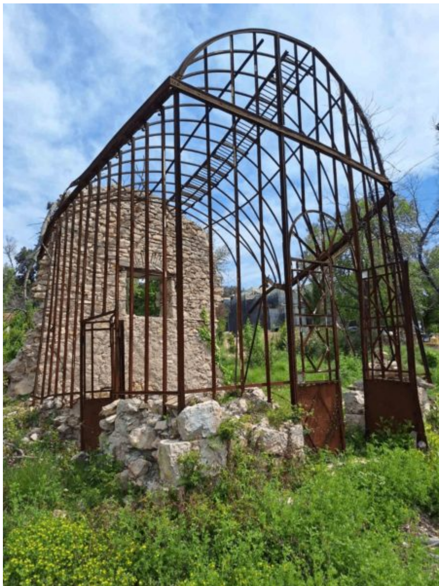
Θερμοκήπιο. Υφιστάμενη κατάσταση
