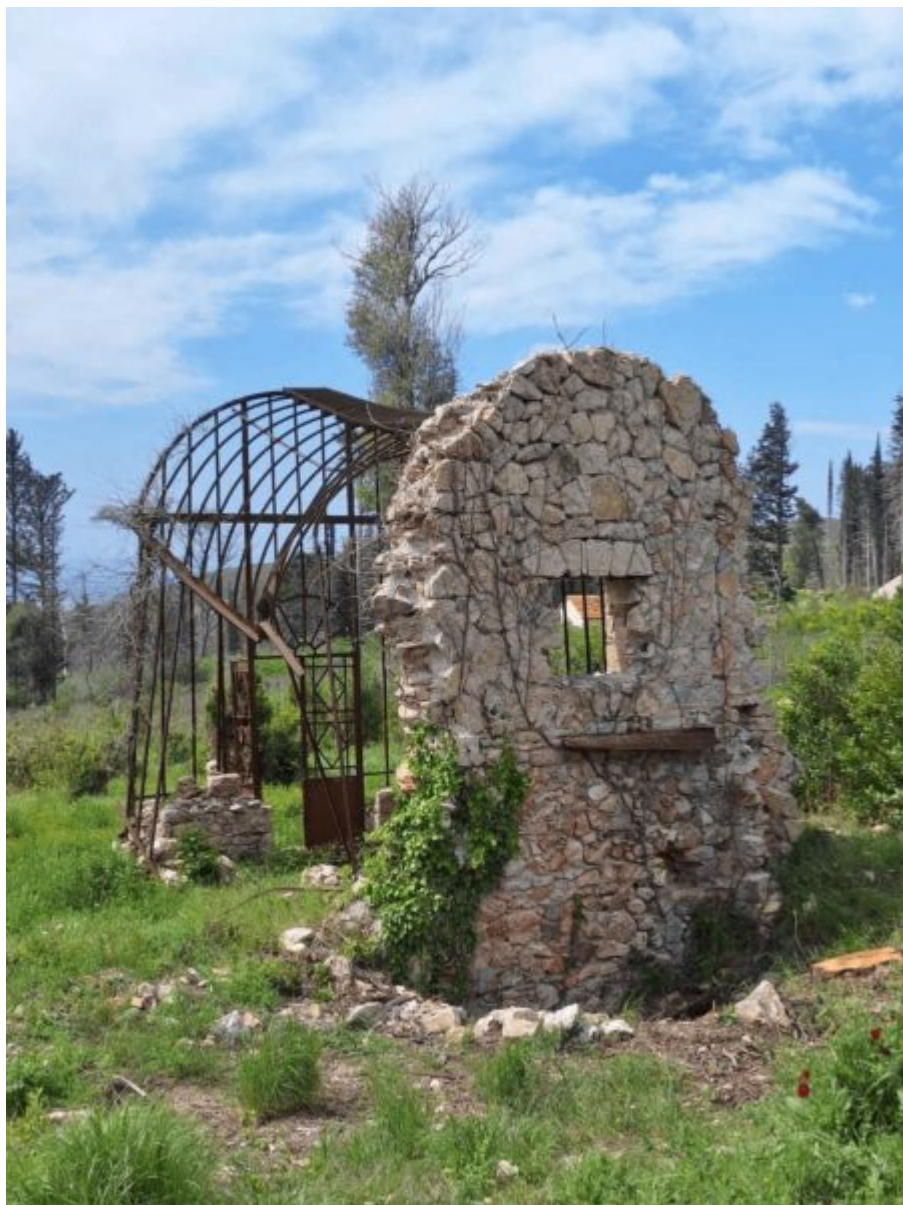
Θερμοκήπιο. Υφιστάμενη κατάσταση
