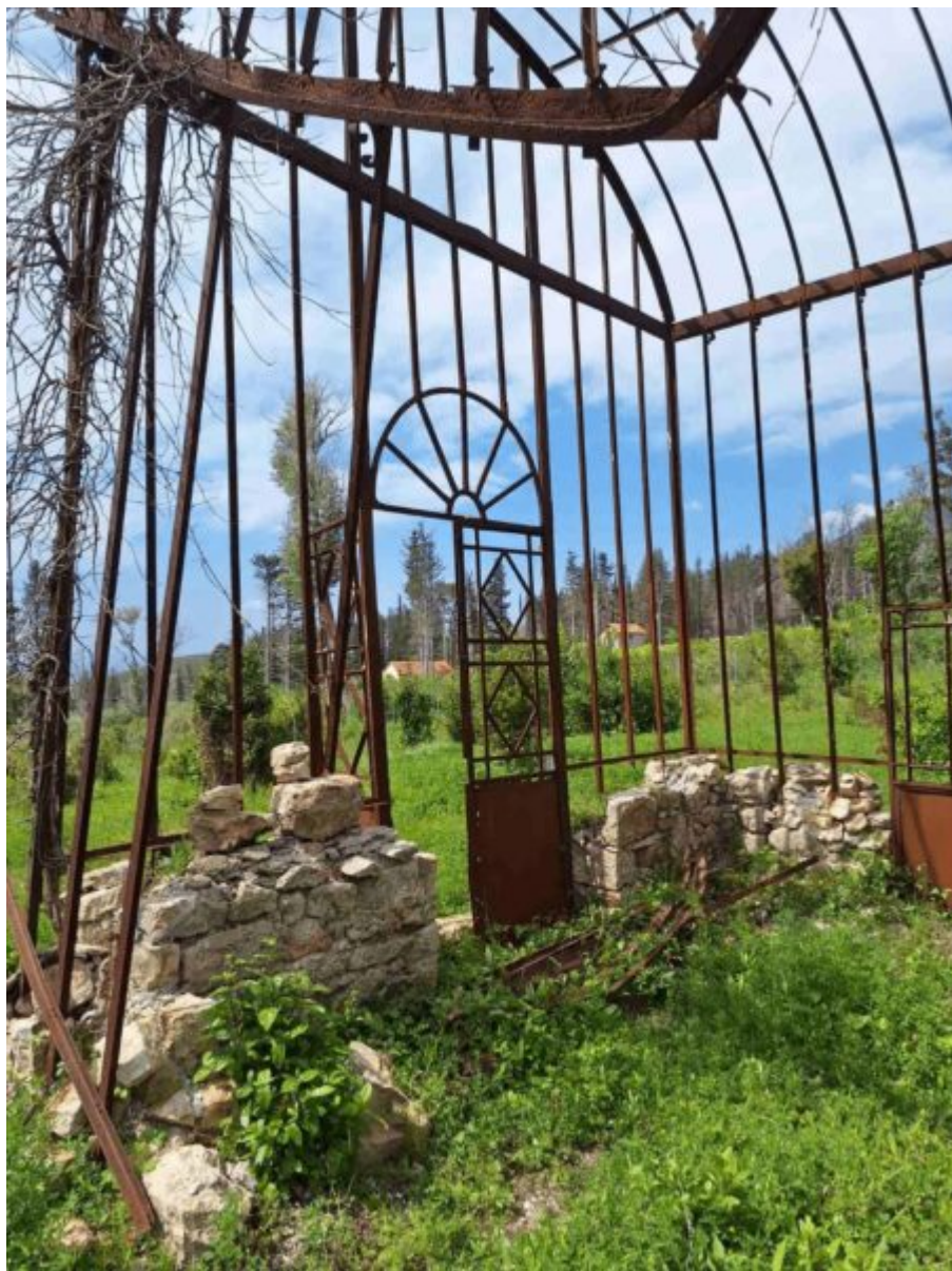
Θερμοκήπιο. Υφιστάμενη κατάσταση
