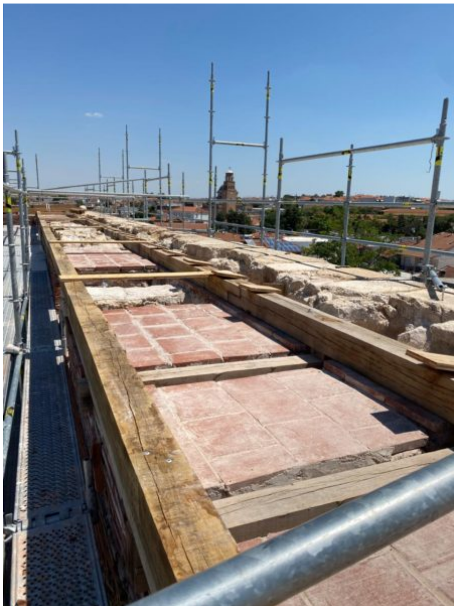
Απόληξη της στέψης των περιμετρικών τοιχοποιιών με τους στρωτήρες
