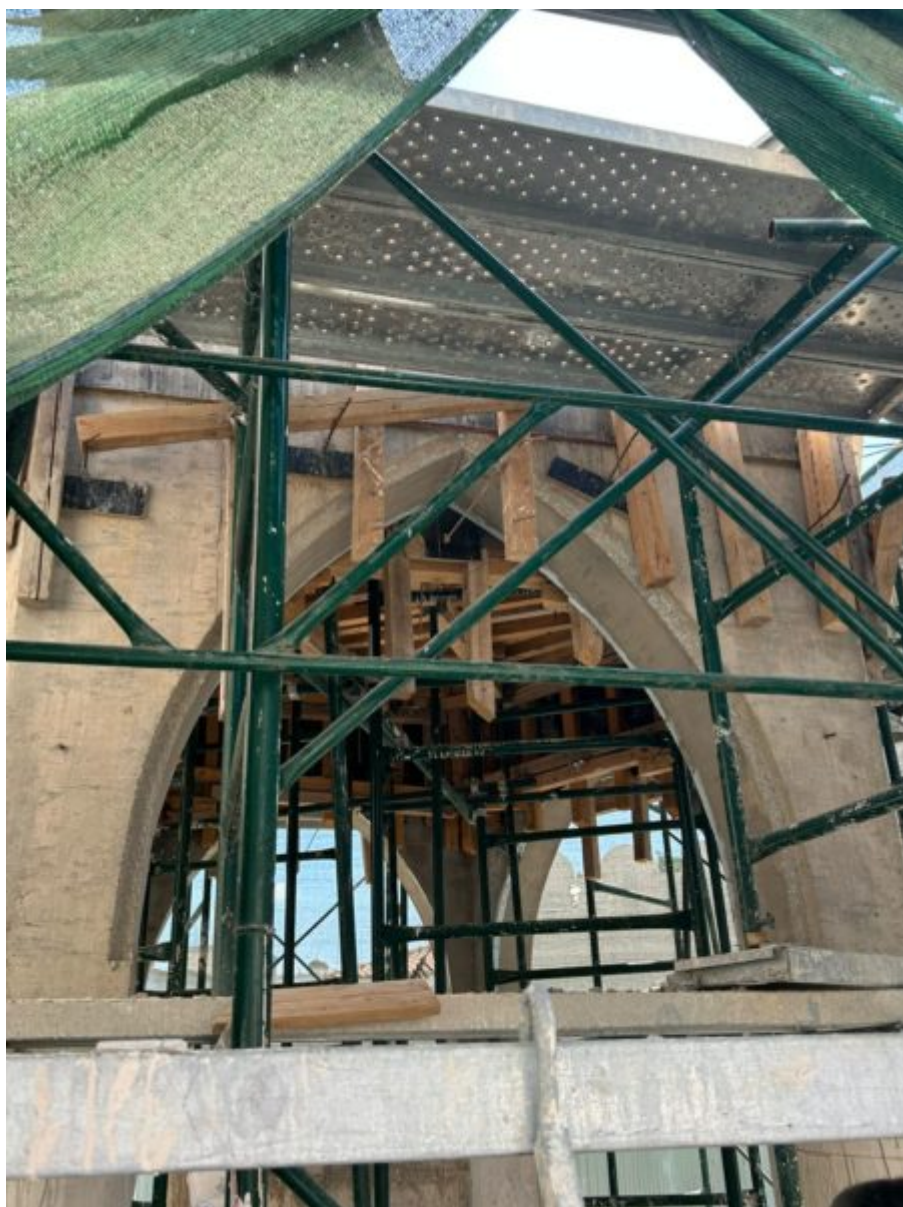
Αναστηλωτικές εργασίες στο τέμενος Defterdar
