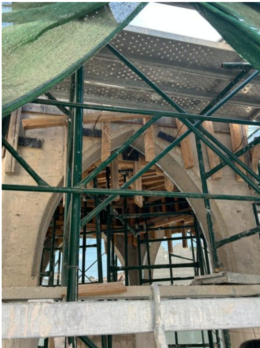
Αναστηλωτικές εργασίες στο τέμενος Defterdar
