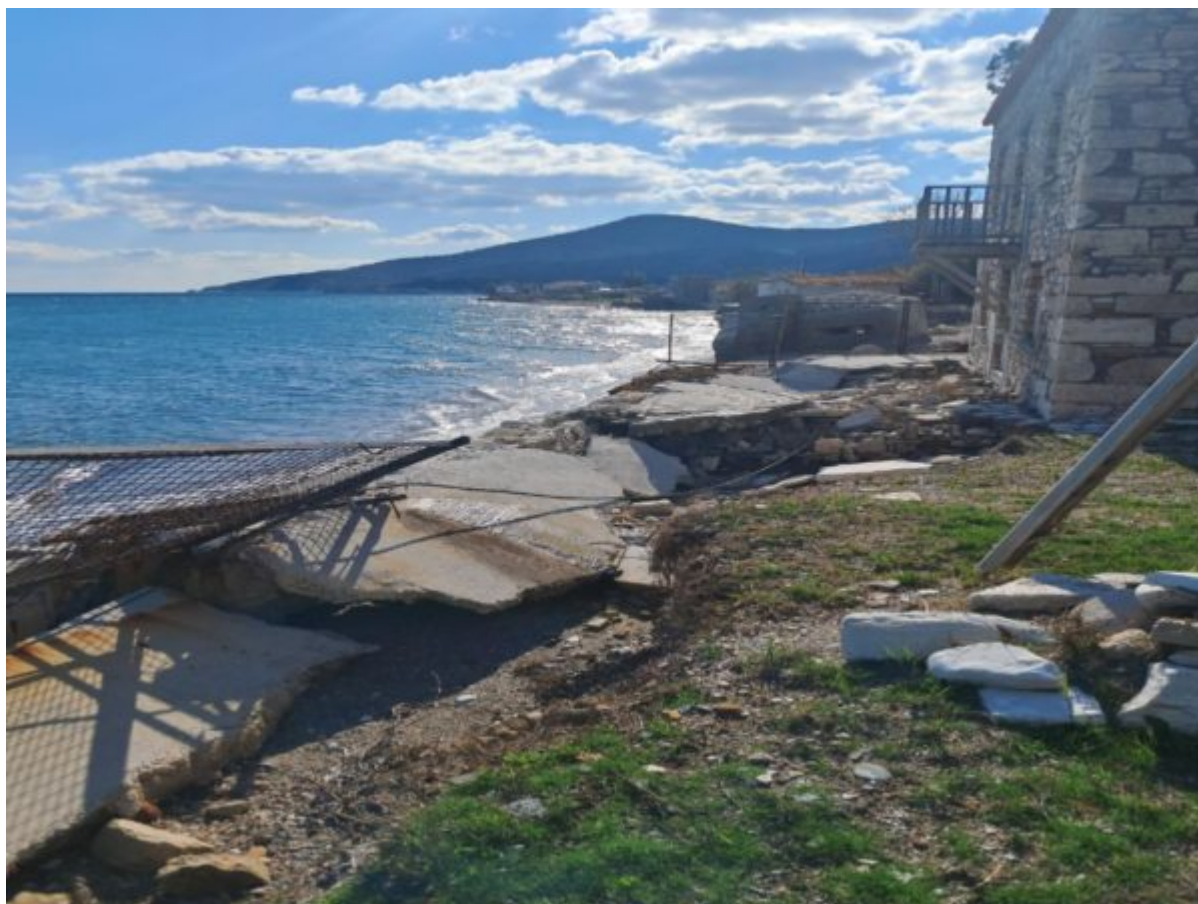
Το παράκτιο μέτωπο και η σχέση του με το αναψυκτήριο. Υφιστάμενη κατάσταση
