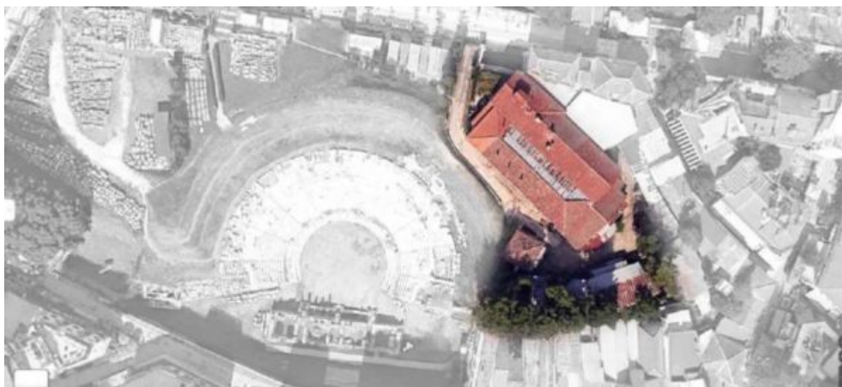
Η θέση των στρατιωτικών αρτοποιείων στον Λόφο του Φρουρίου
