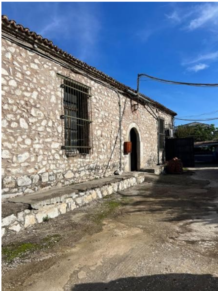
Άποψη του κτηρίου Α1 εξωτερικά
