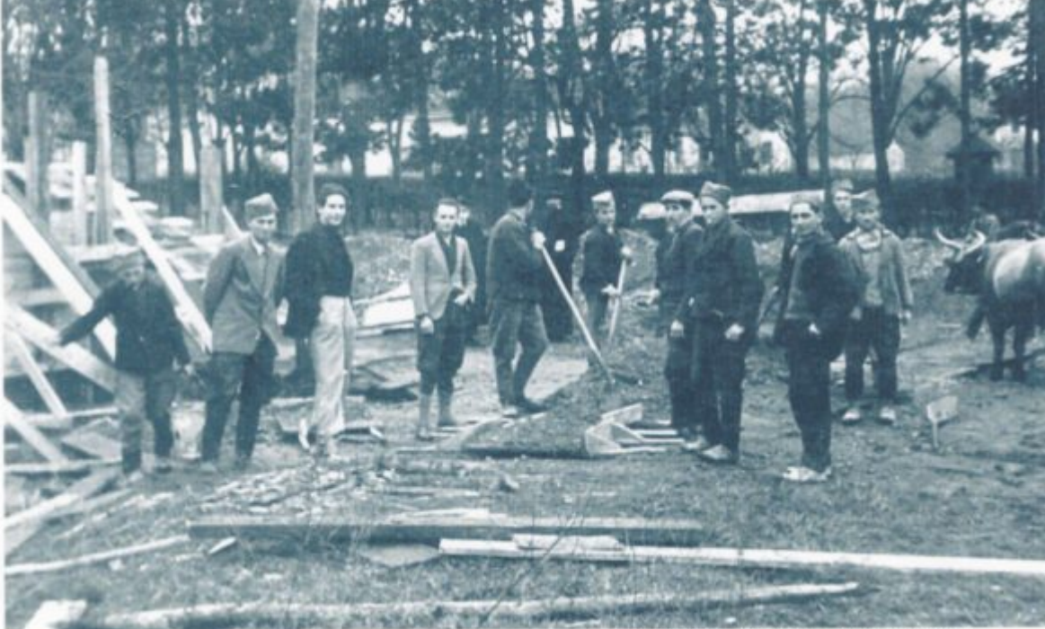
Моба на изградњи старе ковиљачке цркве
