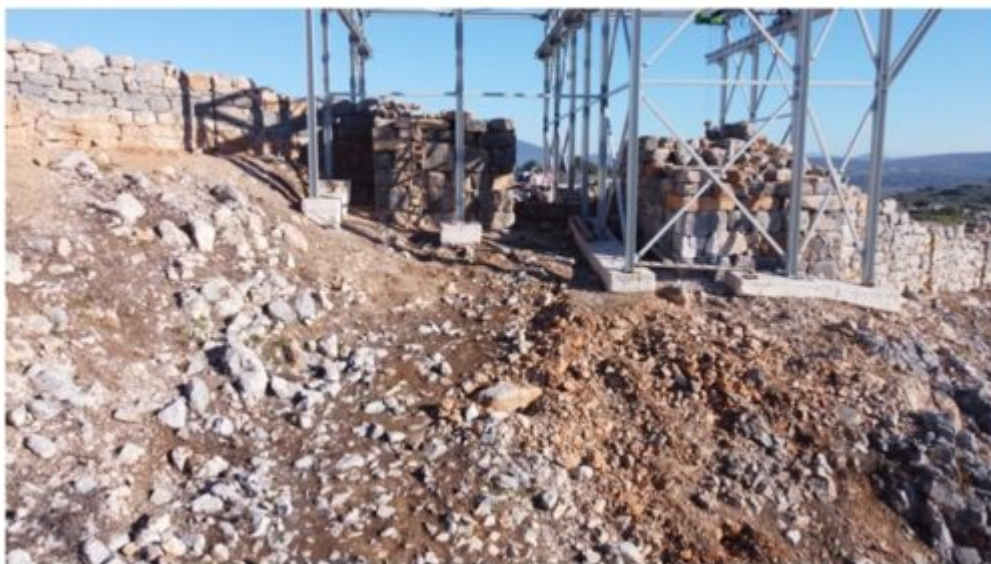
Νότια Πύλη, πριν και κατά τη διάρκεια των εργασιών αποκατάστασης (2022-2025)
