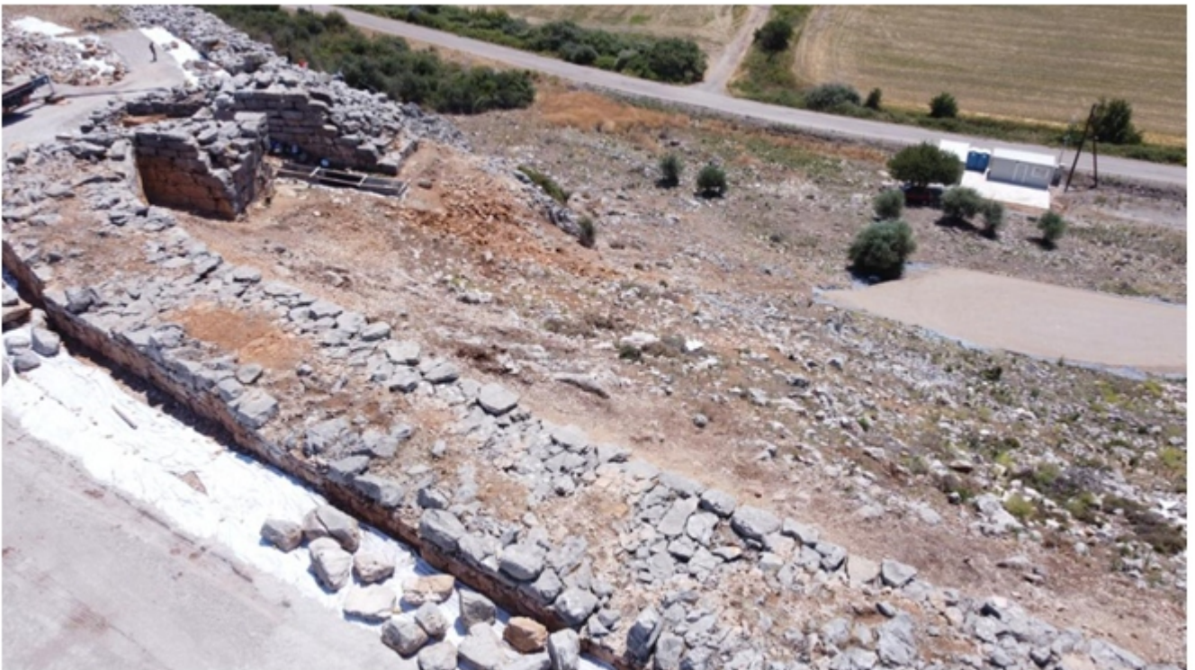
Επίπεδο κυκλοφορίας του τείχους δυτικά της Νότιας Πύλης, πριν και μετά τις εργασίες αποκατάστασης
