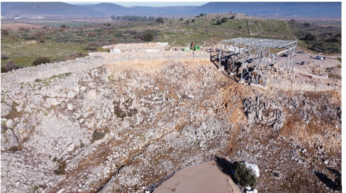
Γενική άποψη της Νότιας Πύλης και τμήματος του τείχους εκατέρωθεν αυτής, πριν και μετά τις εργασίες αναστήλωσης
