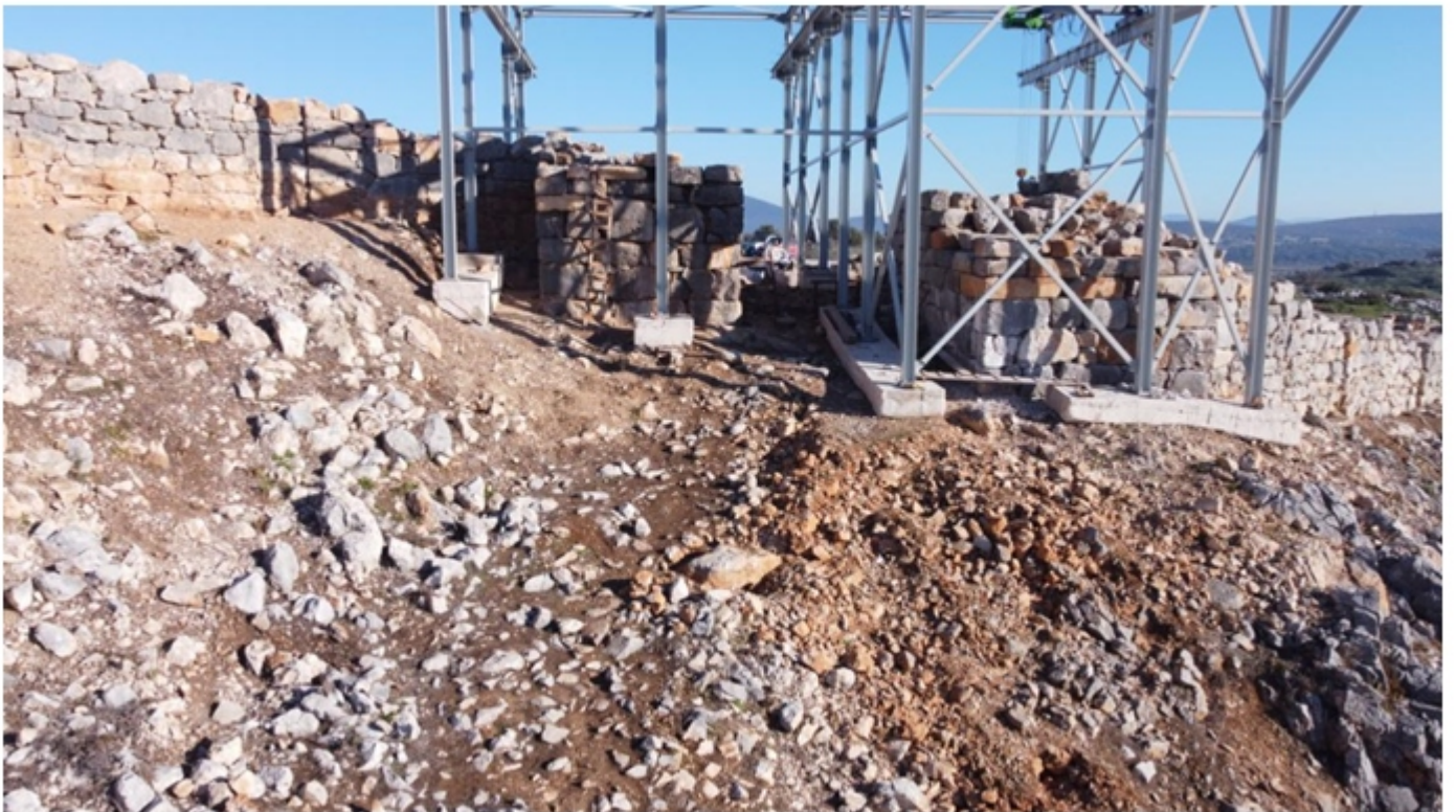
Νότια Πύλη, πριν και κατά τη διάρκεια των εργασιών αποκατάστασης (2022-2025)
