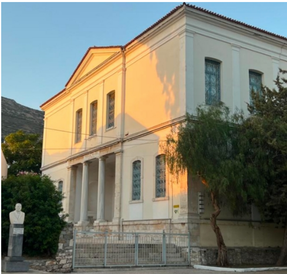
Κτήριο Β εξωτερικά
