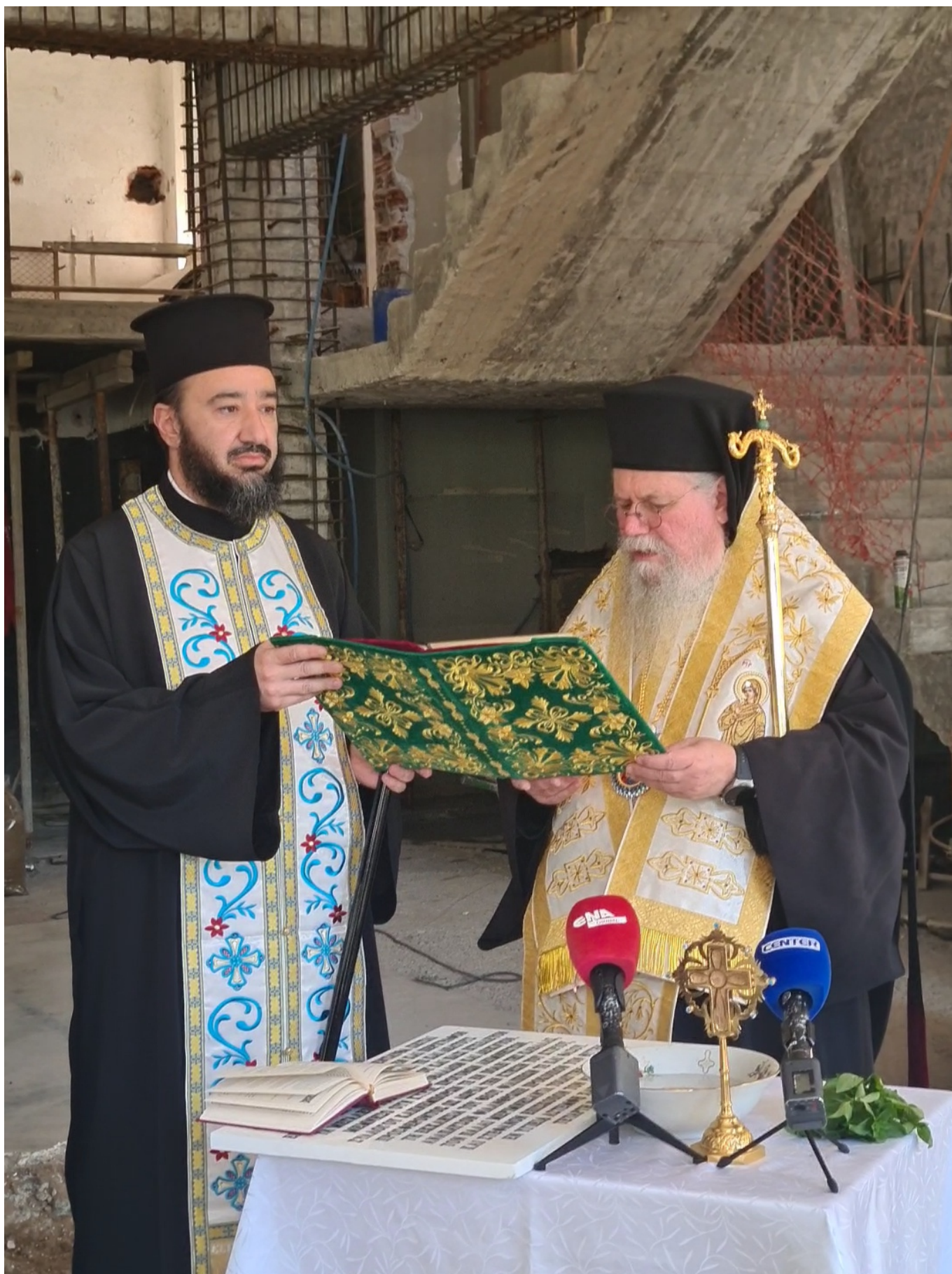
Η εμφανής πρόοδος των ανακατασκευαστικών εργασιών για την επανάχρηση του
