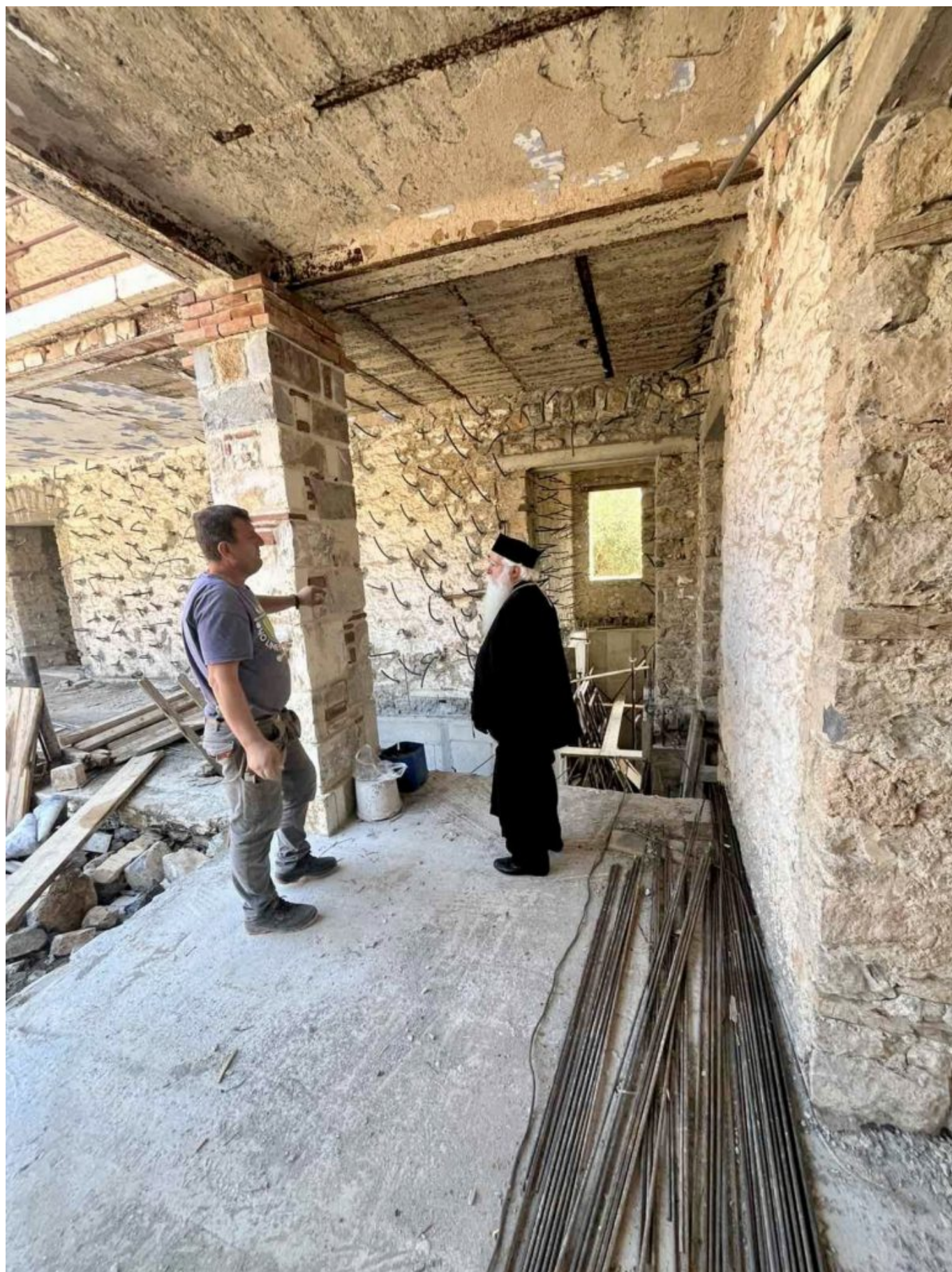
Οι εργασίες που βρίσκονται σε εξέλιξη αποσκοπούν στην πλήρη αναστήλωση και
