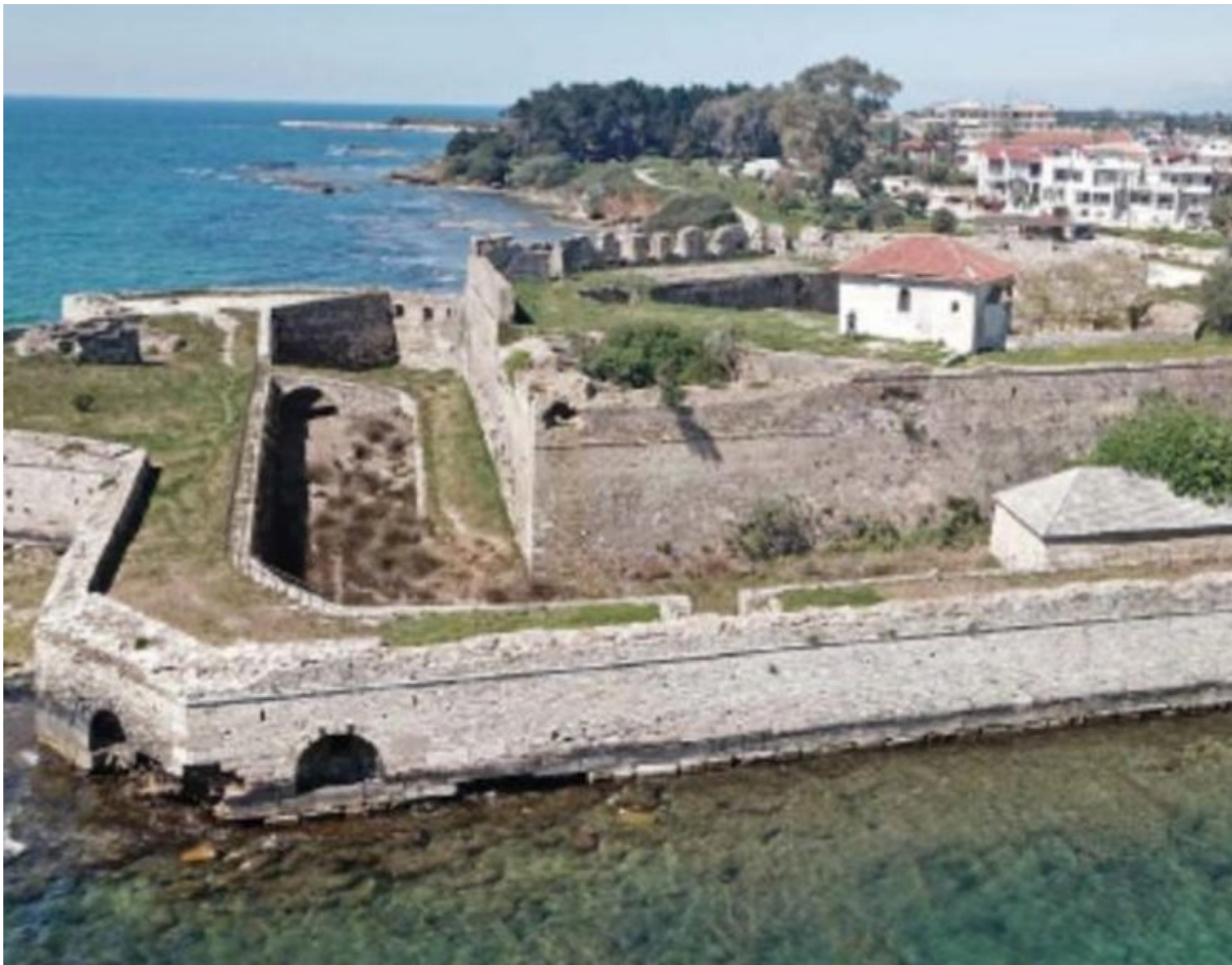
Ο Ναός των Αγίων Αναργύρων στο δώμα του Φρουρίου
