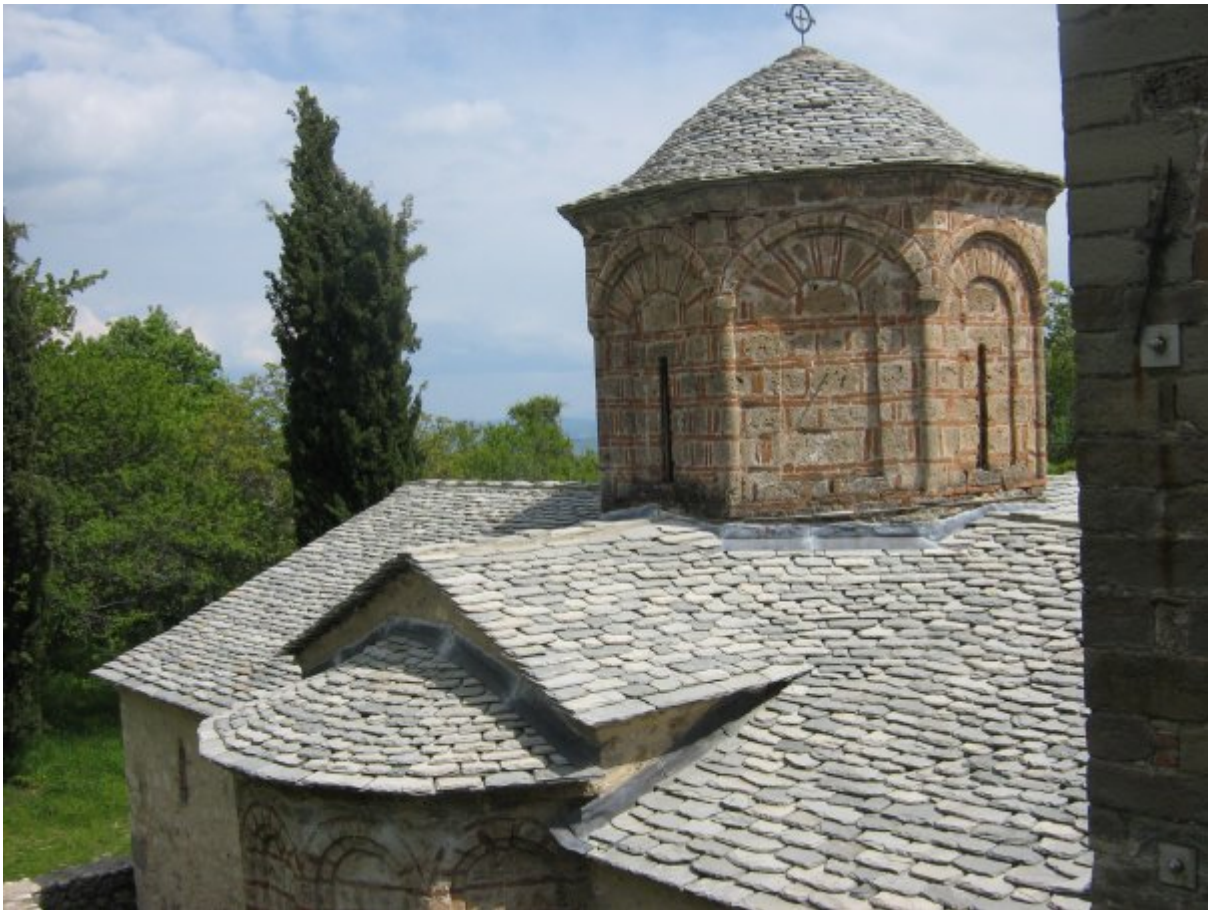
Εκκλησία – Αποκατάσταση Πλακοσκεπής – ΣΠΗΛΑΙΟ ΓΡΕΒΕΝΩΝ – Η Παραδοσιακή Ζουπανιώτικη Τέχνη της Πέτρας
