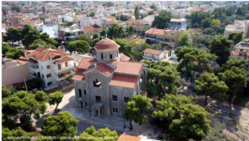
Άποψη τοῦ νέου ἀνεγειρόμενου Ἱ. Ναοῦ (λήψη ἀπὸ ἐλικόπτερο, ἀεροφωτογραφία)
