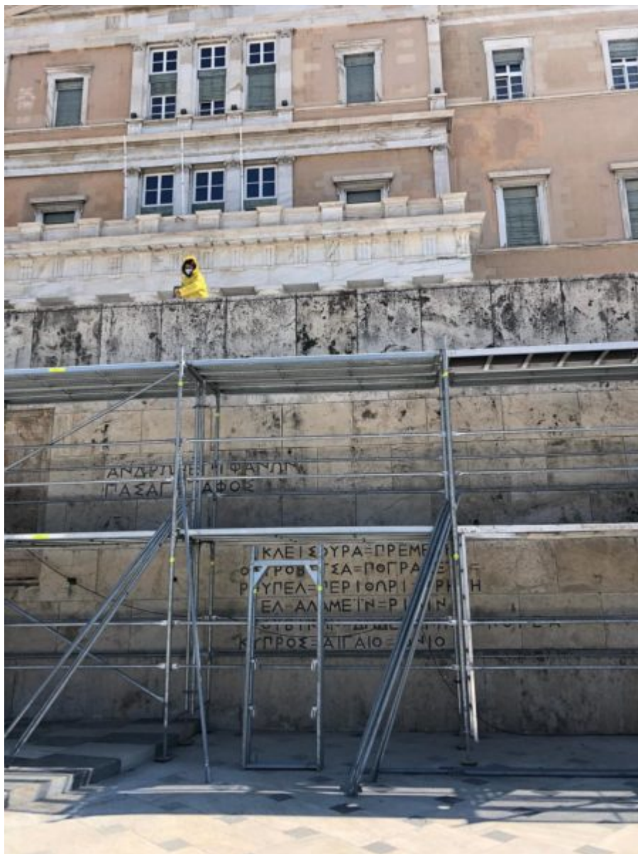
Εργασίες καθαρισμού στο μνημείο του Άγνωστου Στρατιώτη στο Σύνταγμα από το ΥΠΠΟΑ
