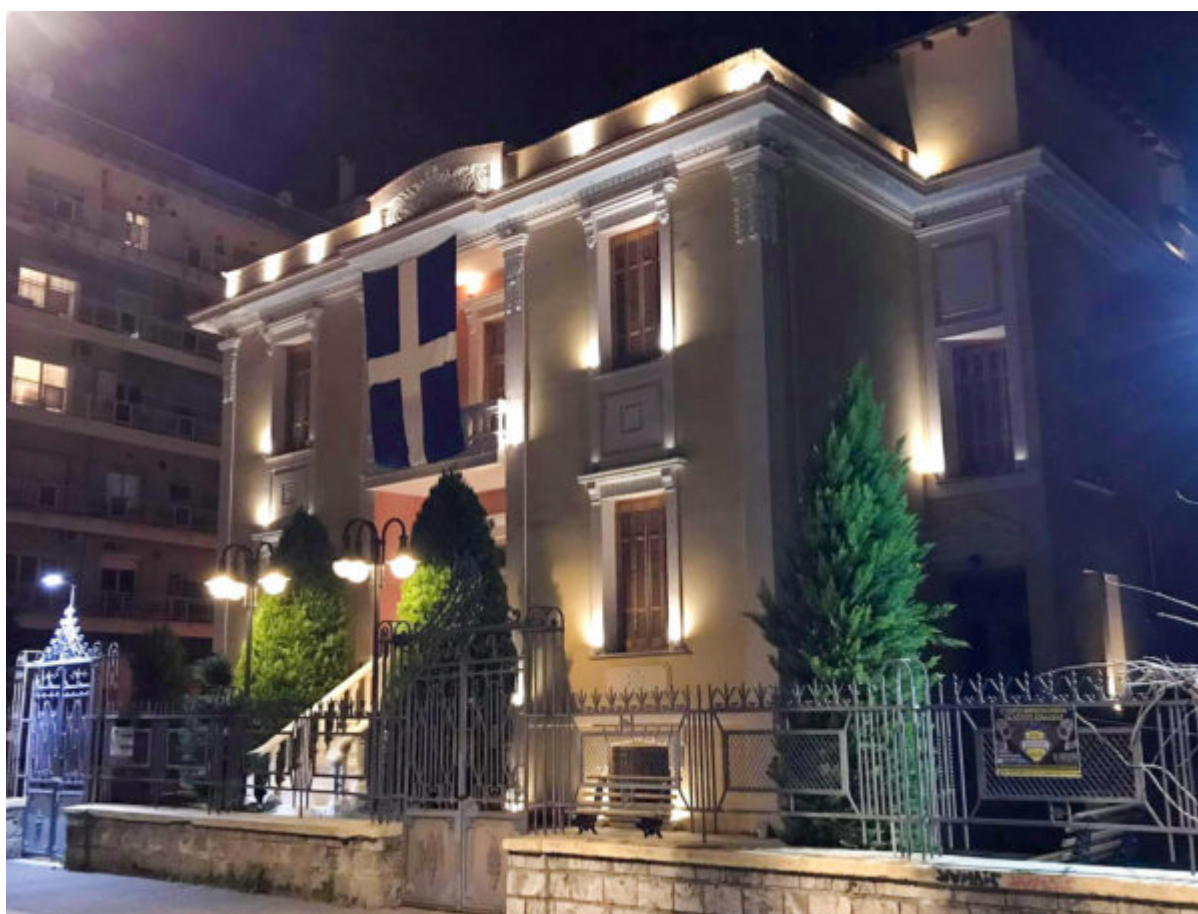
Το Βλαχογιάννειο Μουσείο βρίσκεται στην οδό Ανοίξεως στο πάρκο των Αγ.
