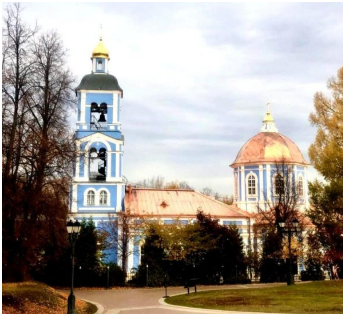
7) Объект культурного наследия регионального значения «Церковь Знамени, 1784 г., г.Москва, Рязанский пр-т, д. 3, стр. 1» (продолжение реставрационных работ).
