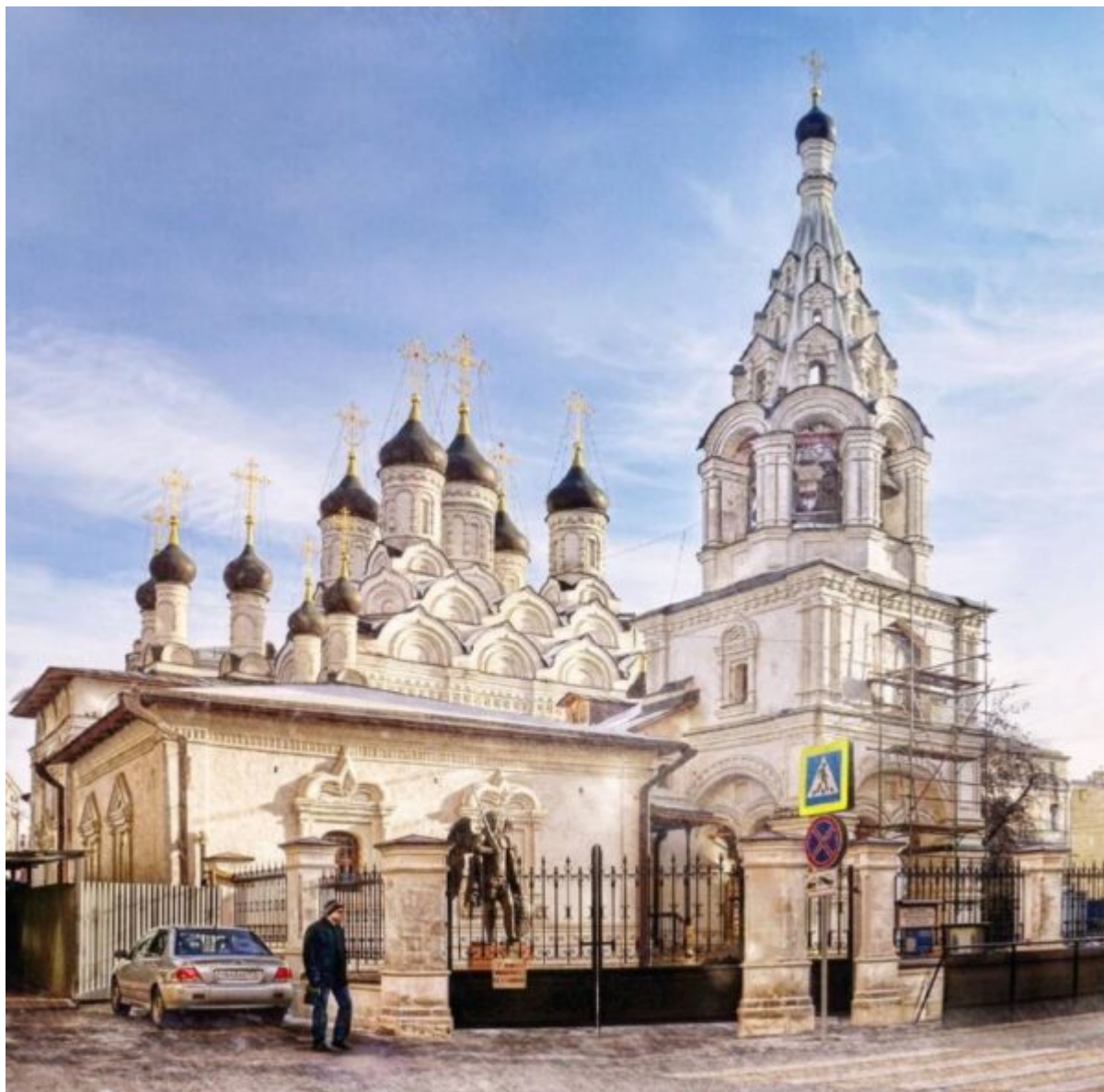
б) Объект культурного наследия федерального значения «Ансамбль усадьбы Царицыно, XVIII в. – Церковь» г.Москва, ул. Дольская, д. 2, стр. 1 (продолжение реставрационных работ);
