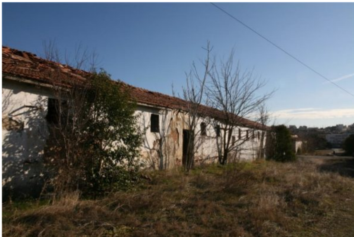
Το κτήριο Β4 το 2012, πριν την πυρκαγιά που κατέστρεψε τη στέγη του
