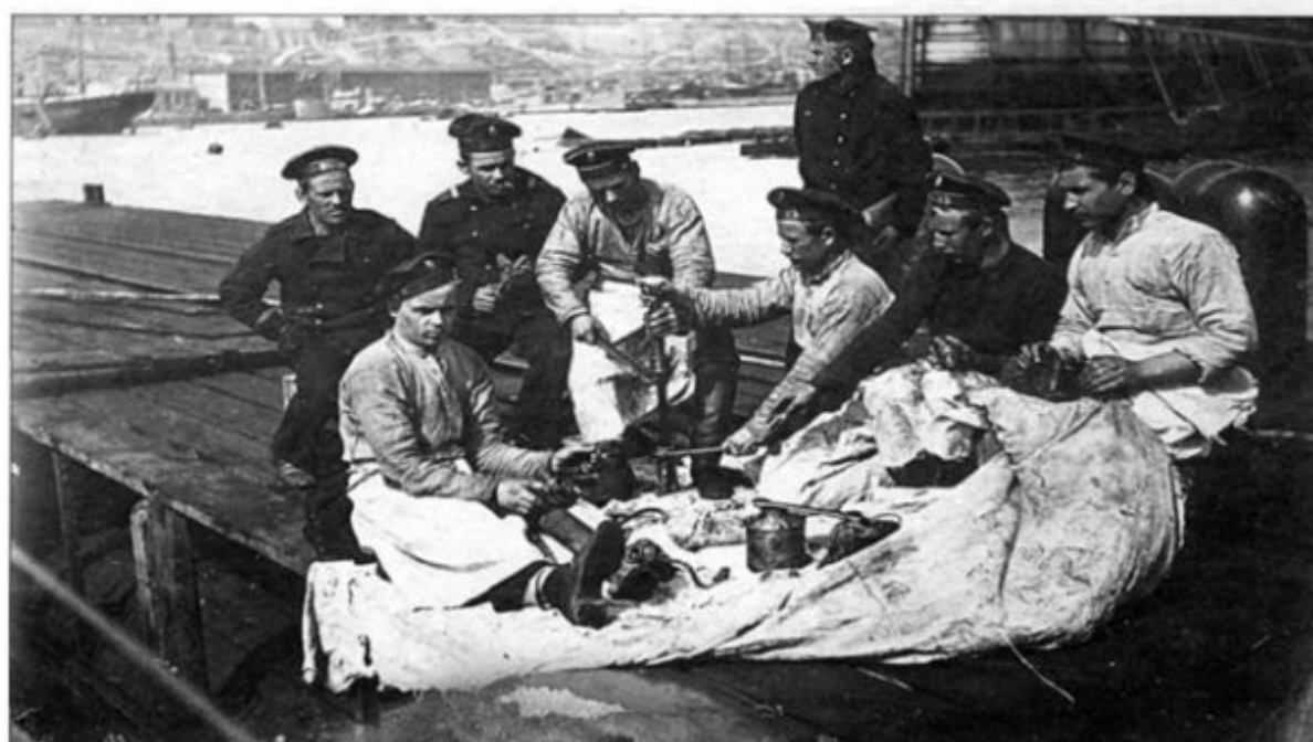
Внизу: группа матросов с «Моржа» на пирсе подплава в Южной бухте Севастополя занимается переборкой и смазкой штока гидроцилиндра одного из бортовых ТА системы Дзевецкого.
