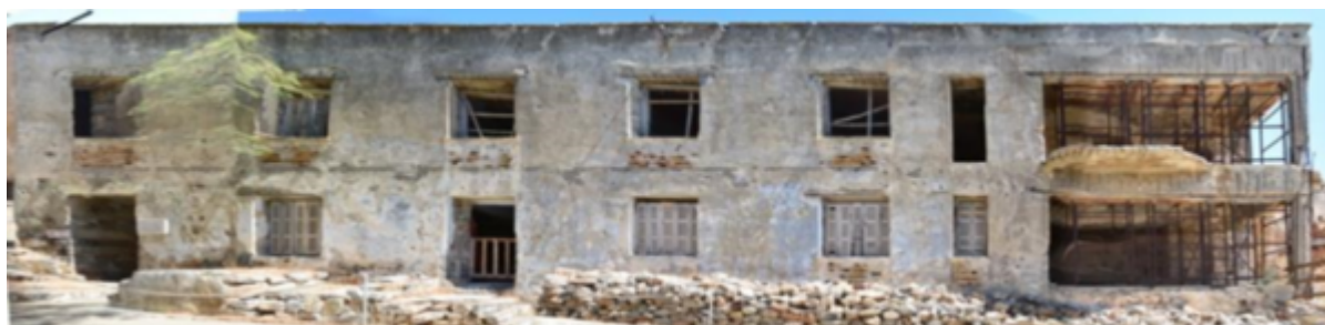
Νότιο Κτήριο Λεπροκομείου
