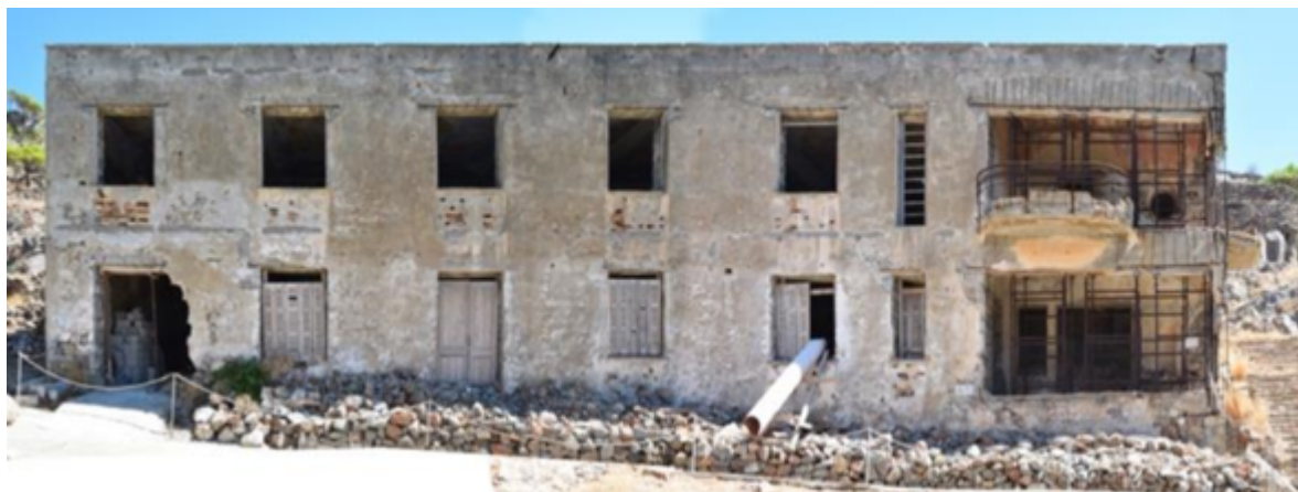
Βόρειο Κτήριο Λεπροκομείου
