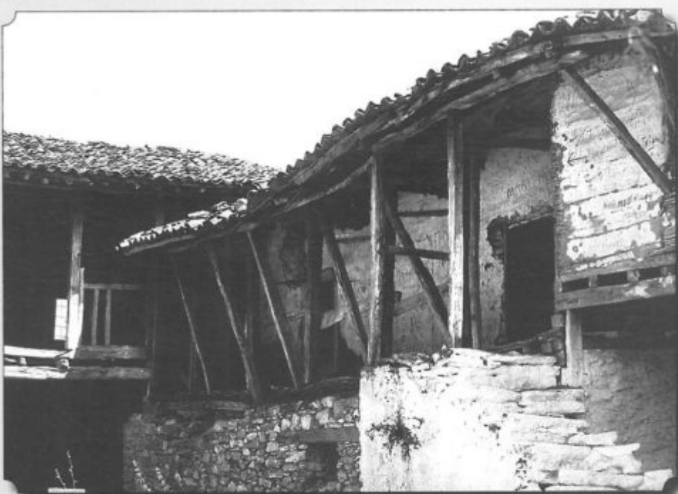
Εσωτερική όψη της νοτιοανατολικής γωνίας του περιβολού (1970, φωτ. της άποστολής Κουμονλίδη, στο Άρχείο της μονής). (Είκ. 2)
