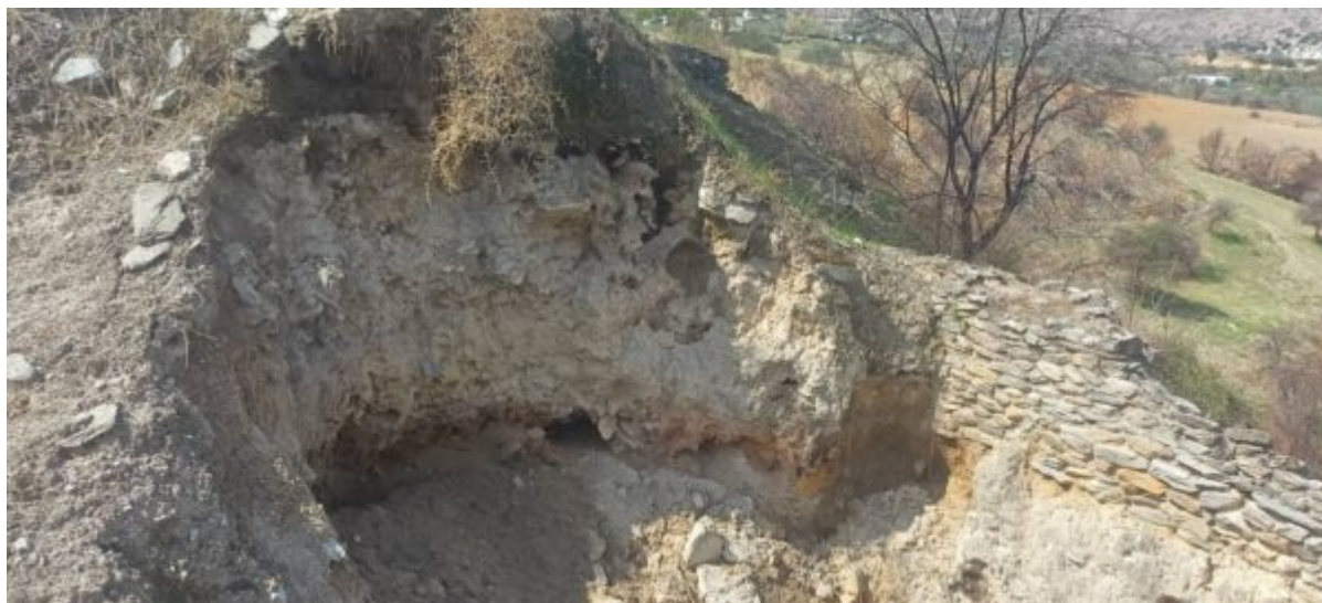
Κατολίσθηση στον Αρχαιολογικό Χώρο Σέσκλου
