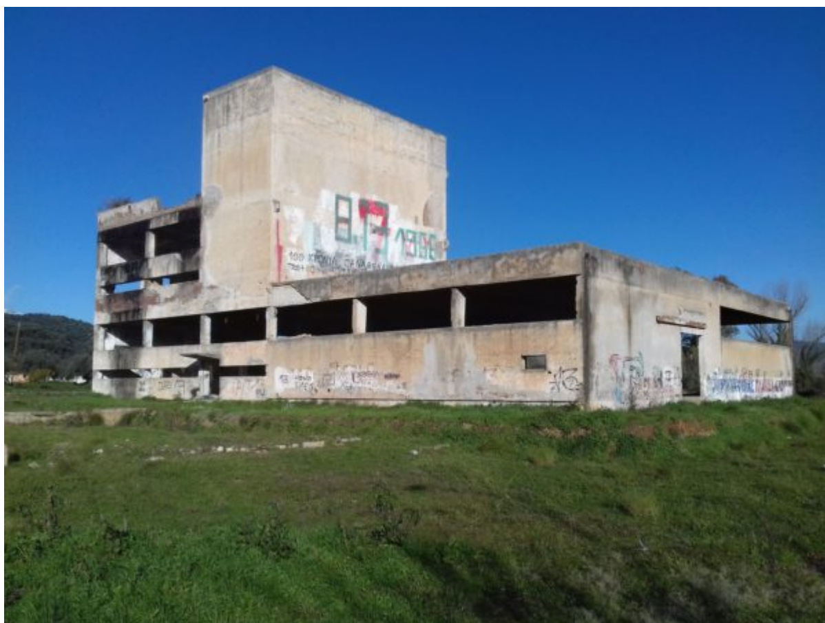
Υφιστάμενη κατάσταση διατηρητέου κτηρίου ΧΥΜΟΦΙΞ
