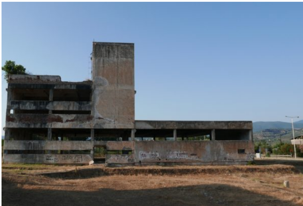
Υφιστάμενη κατάσταση διατηρητέου κτηρίου ΧΥΜΟΦΙΞ
