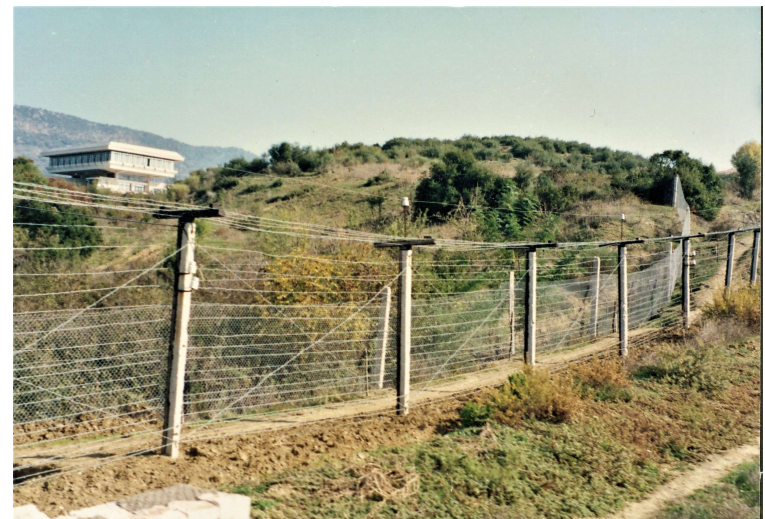
Τα ηλεκτροφόρα συρματοπλέγματα ύψους 2,5 μ. Στο βάθος διακρίνεται το Αλβανικό τελωνείο.
