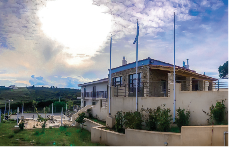
7. Στέγη ύποστηριζόμενης διαβίωσης, Γλυφάδα - Άττική. Foundation of supported shelters, Glyfada - Attica.
