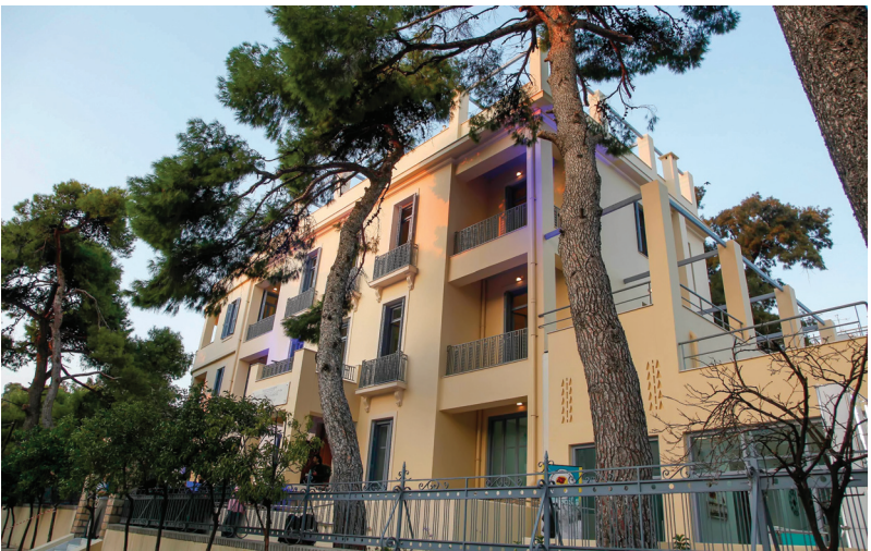
8. Κεντρικό κτίριο του Καρελλείου Προτύπου Κέντρου Alzheimer, Χαλάνδρι - Άττική. Central Building of Alzheimer Disease Unit, Chalandri - Attica.
