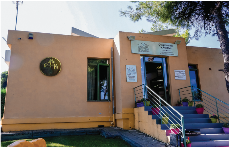
12. Παιδικός Σταθμός, Δήλεσι - Βοιωτία. Nurcery School, Dilesi - Viotia.
